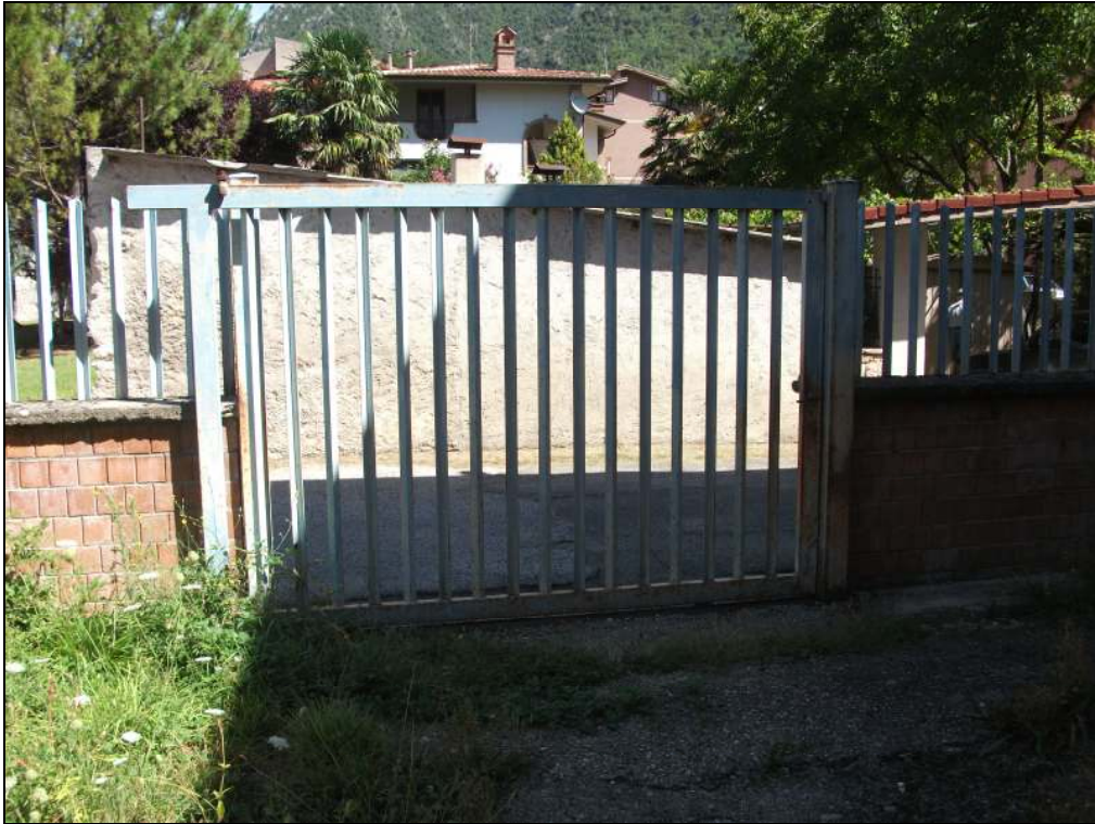
Foto 3 - ingresso derrate alimentari per mezzo di cancello su Via Battaglione Alpini L'Aquila
