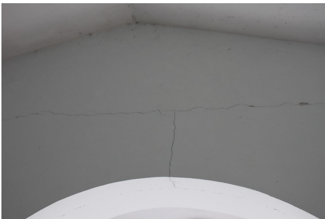
Figura 12 – Lesione all'interno della camera mortuaria
