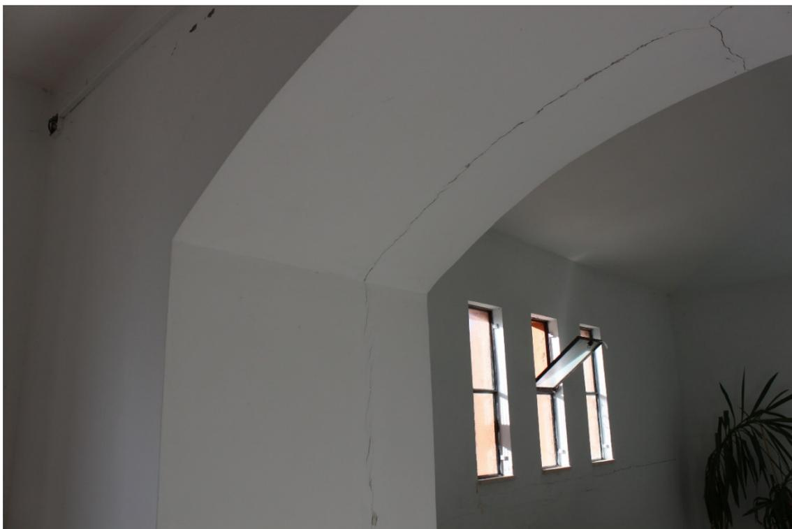
**Figura 11 – Lesione all'interno della camera mortuaria generata da due elementi realizzati in
