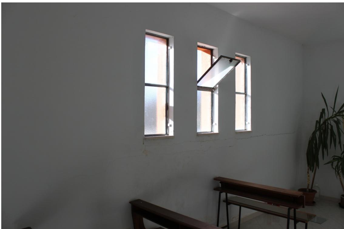
Figura 10 – Lesione generata dalla concentrazione degli sforzi di taglio dovuti alla presenza delle
