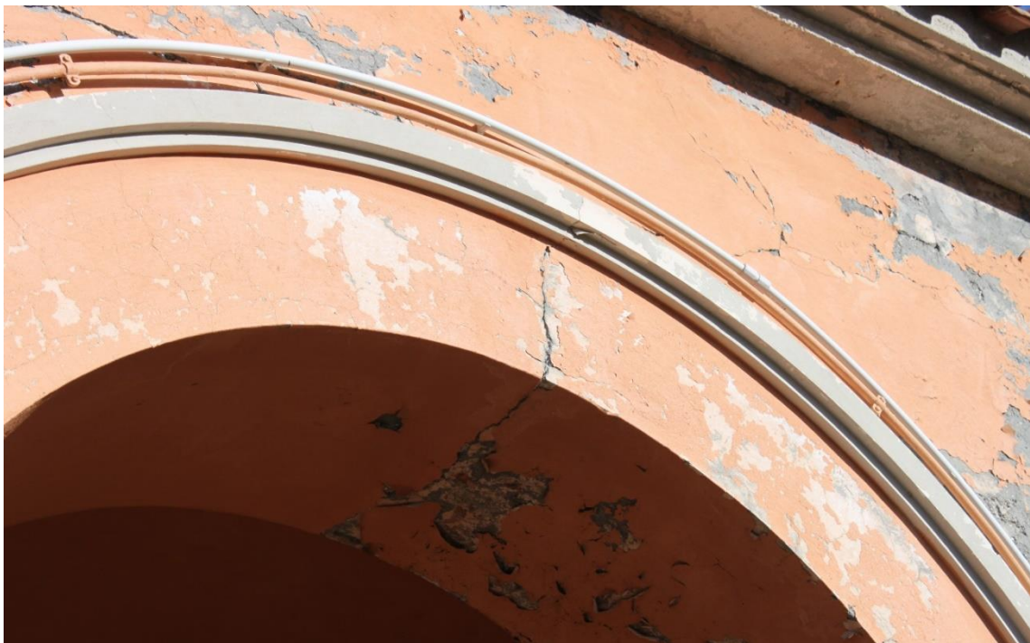
Figura 08 – Lesione in chiave dell'arco
