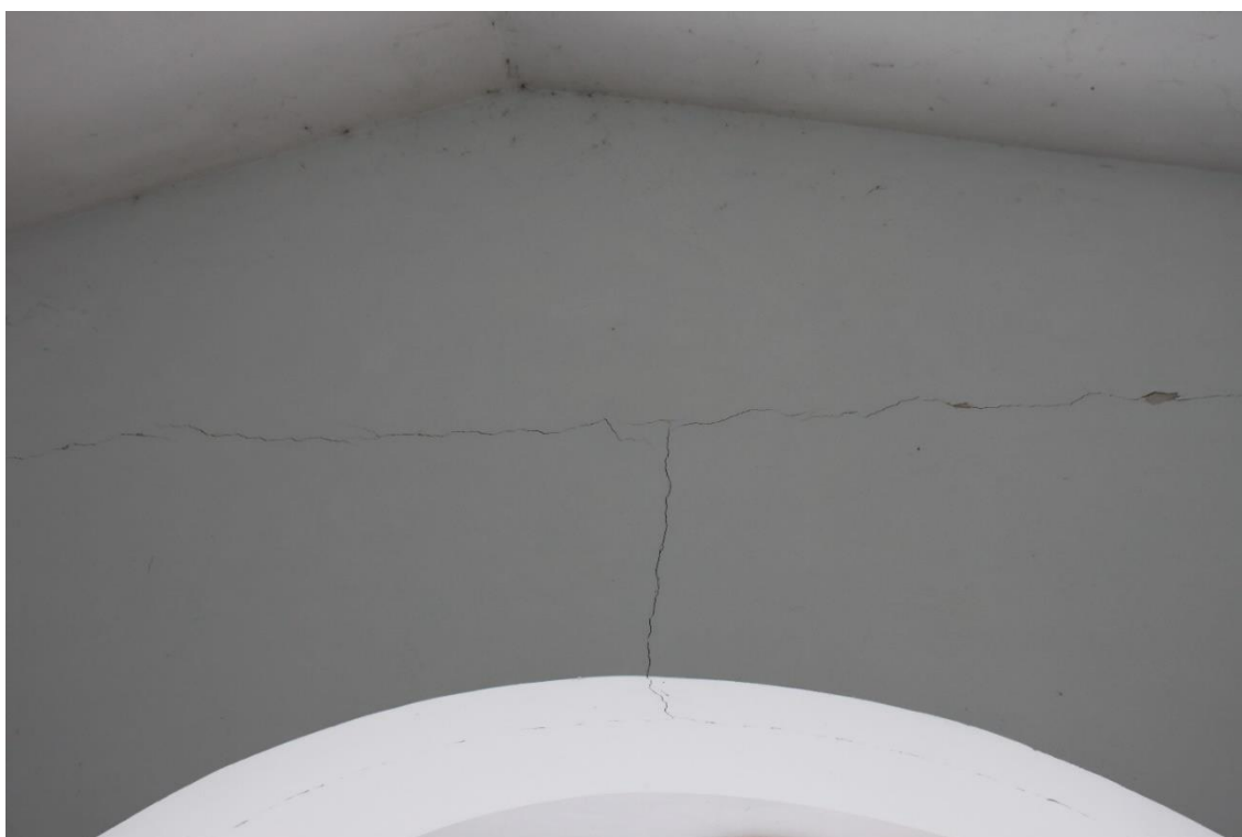
Figura 12 – Lesione all'interno della camera mortuaria
