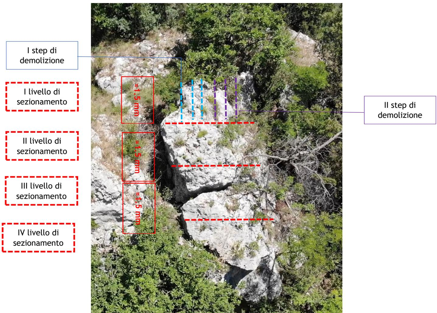
**Figura n. 31 - Sezionamento per demolizione controllata**
