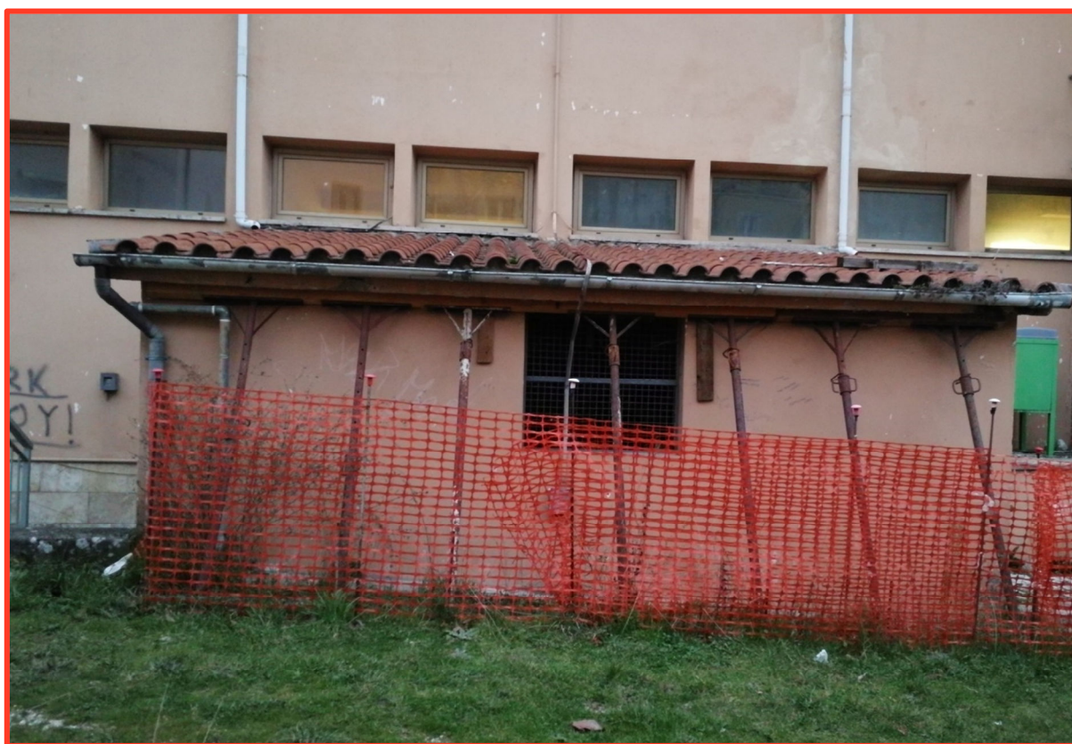
Vista esterna della centrale con particolare della messa in sicurezza
