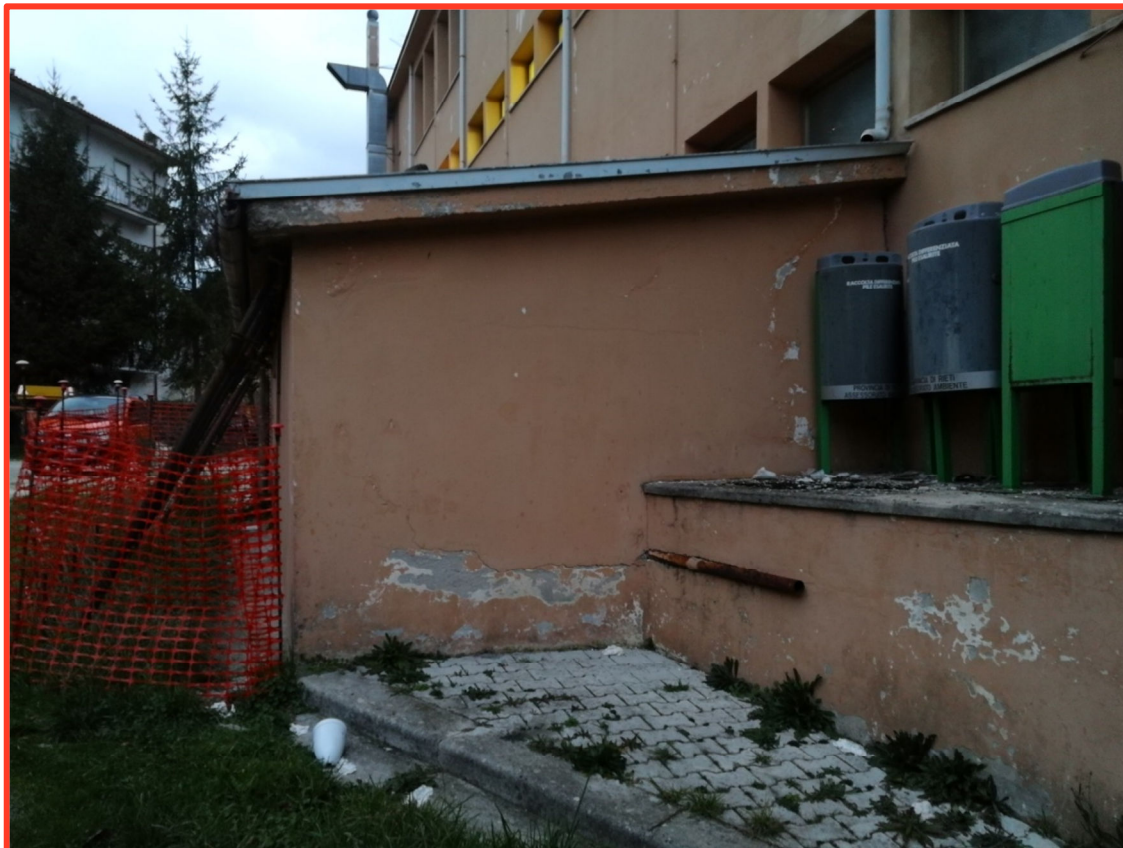
Vista esterna della centrale
