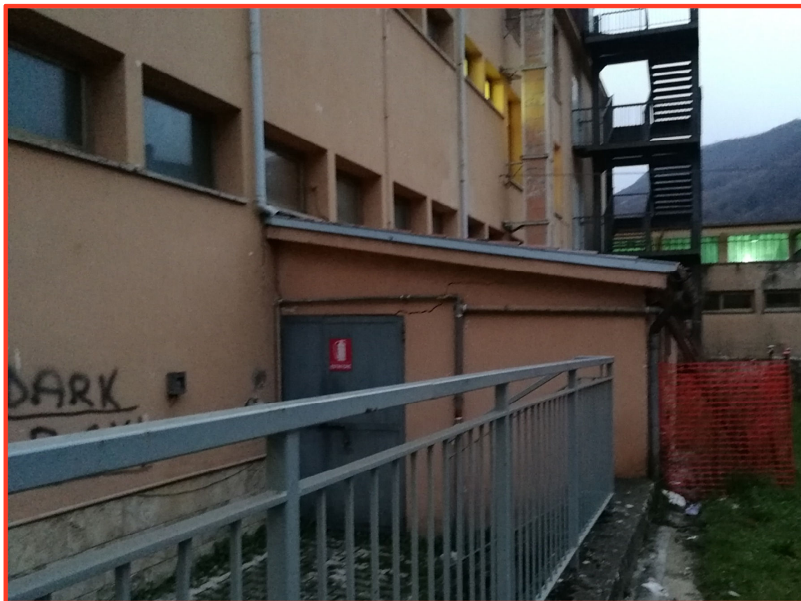
Vista esterna della centrale termica oggetto di intervento
