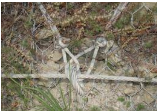
DETTAGLIO ANCORAGGIO AL PIEDE
