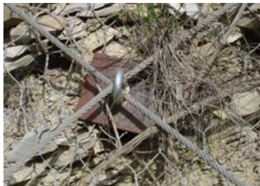
DETTAGLIO PIASTRA CHIODATURA
