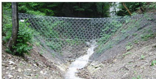
barriera è satura di detriti e la colata fluisce al di sopra della struttura. Tali barriere flessibili sono indicativamente composte da rete di acciaio preformata ad anelli, sostenuta da ancoraggi flessibili, adeguatamente protetti per la parte affiorante, e da ancoraggi in barra, per le sottofondazioni dei montanti in acciaio zincati a caldo;
