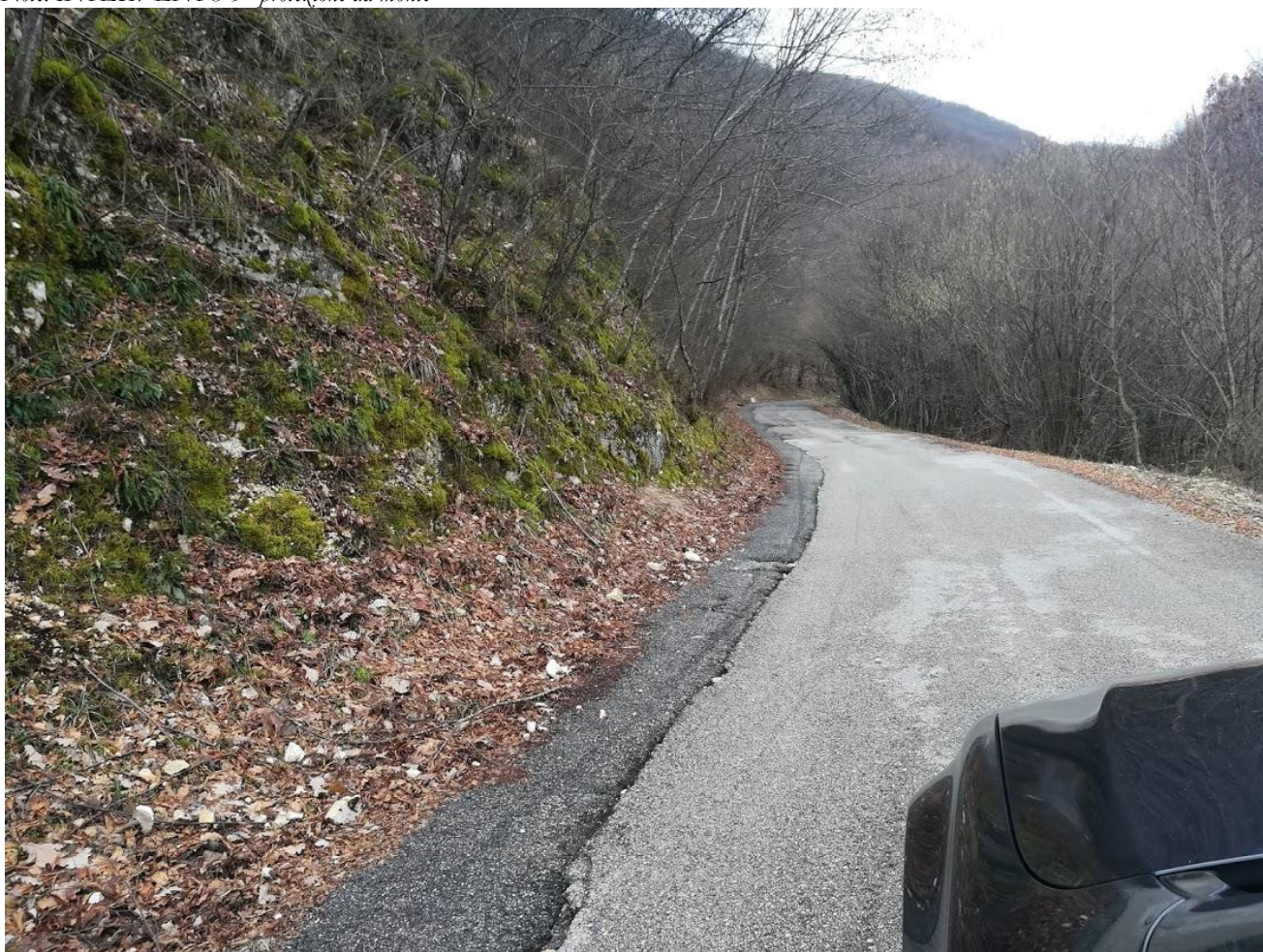
Note: INTERVENTO 5 "protezione da monte 2"
