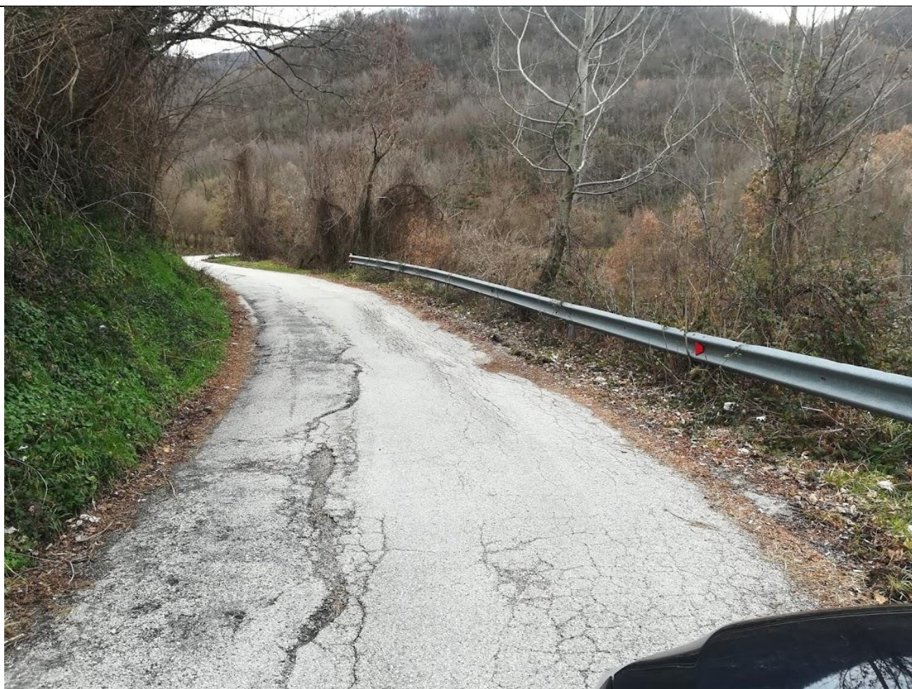
Note: INTERVENTO 6 "paratia 2"
