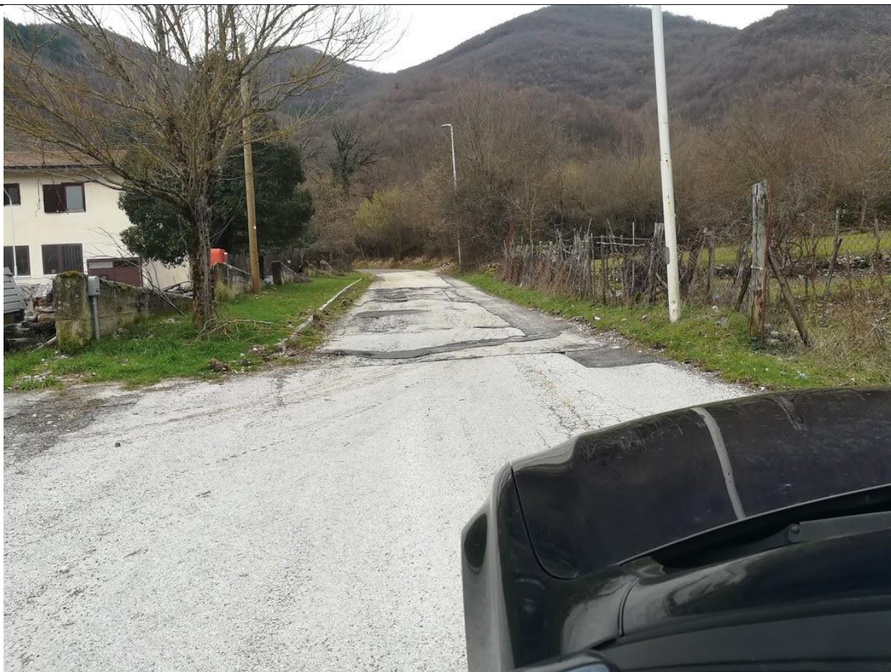
Note: INTERVENTO 3 "manutenzione regimazione"
