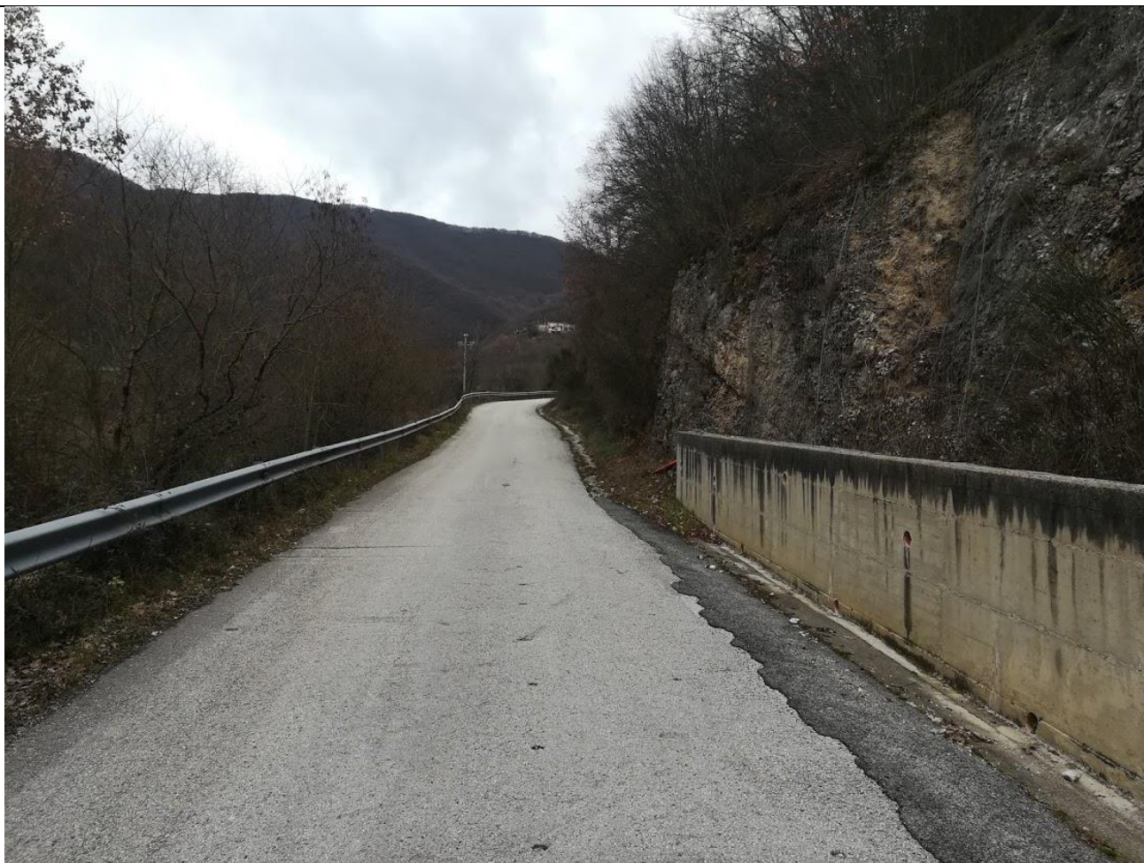
Note: INTERVENTO 2 "protezione da monte"
