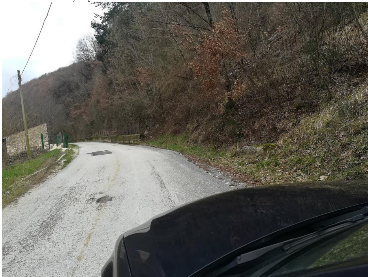
Note: INTERVENTO 2 "protezione da monte 1"
