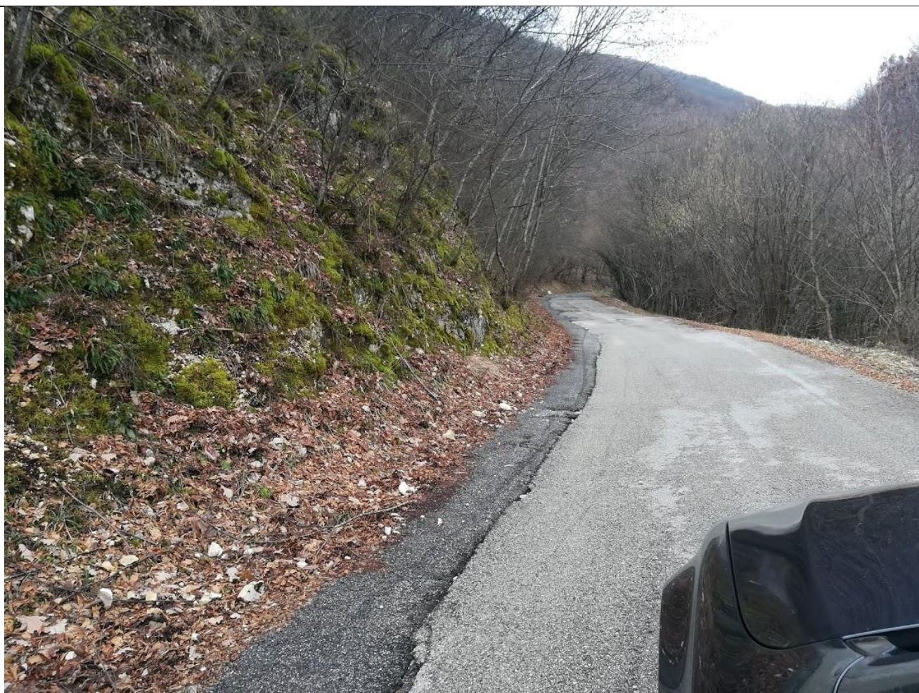
Note: INTERVENTO 5 "protezione da monte 3"
