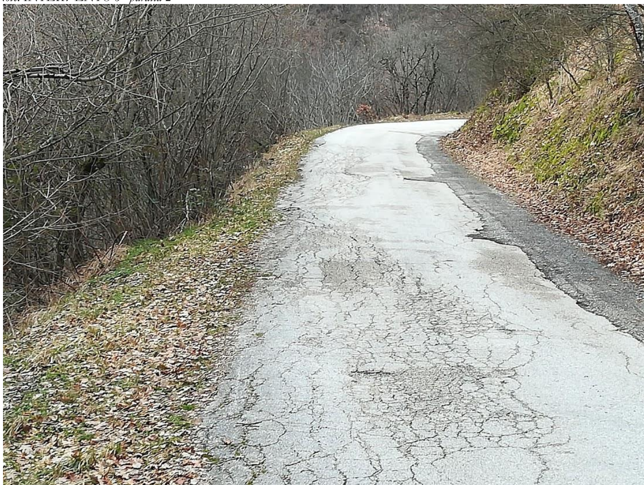
Note: INTERVENTO 7 "paratia"
