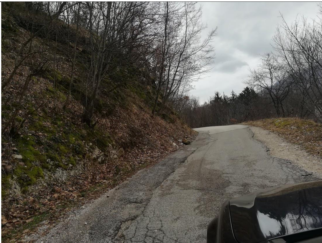
Note: INTERVENTO 5 "protezione da monte"
