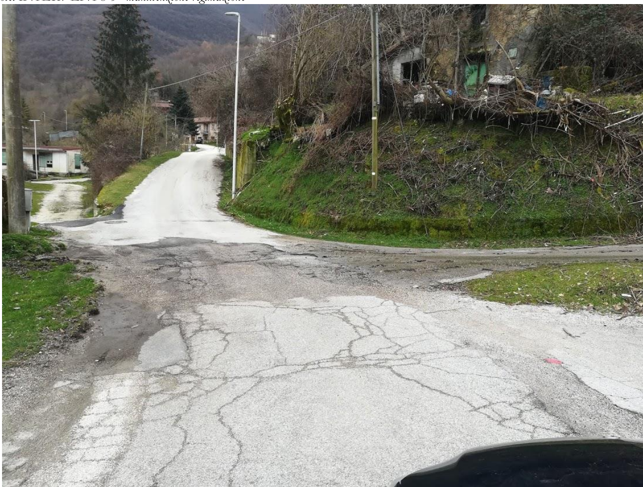
Note: INTERVENTO 3 "manutenzione regimazione 1"
