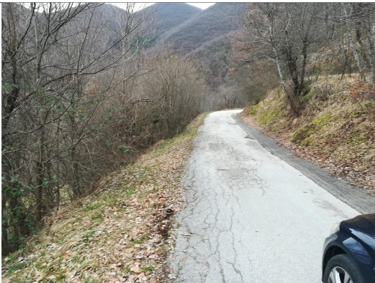
Note: INTERVENTO 7 "paratia 2"
