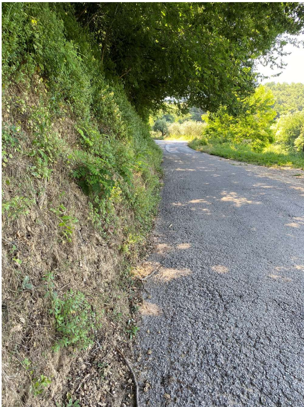
Foto 6 – Sez 2 lato sx
