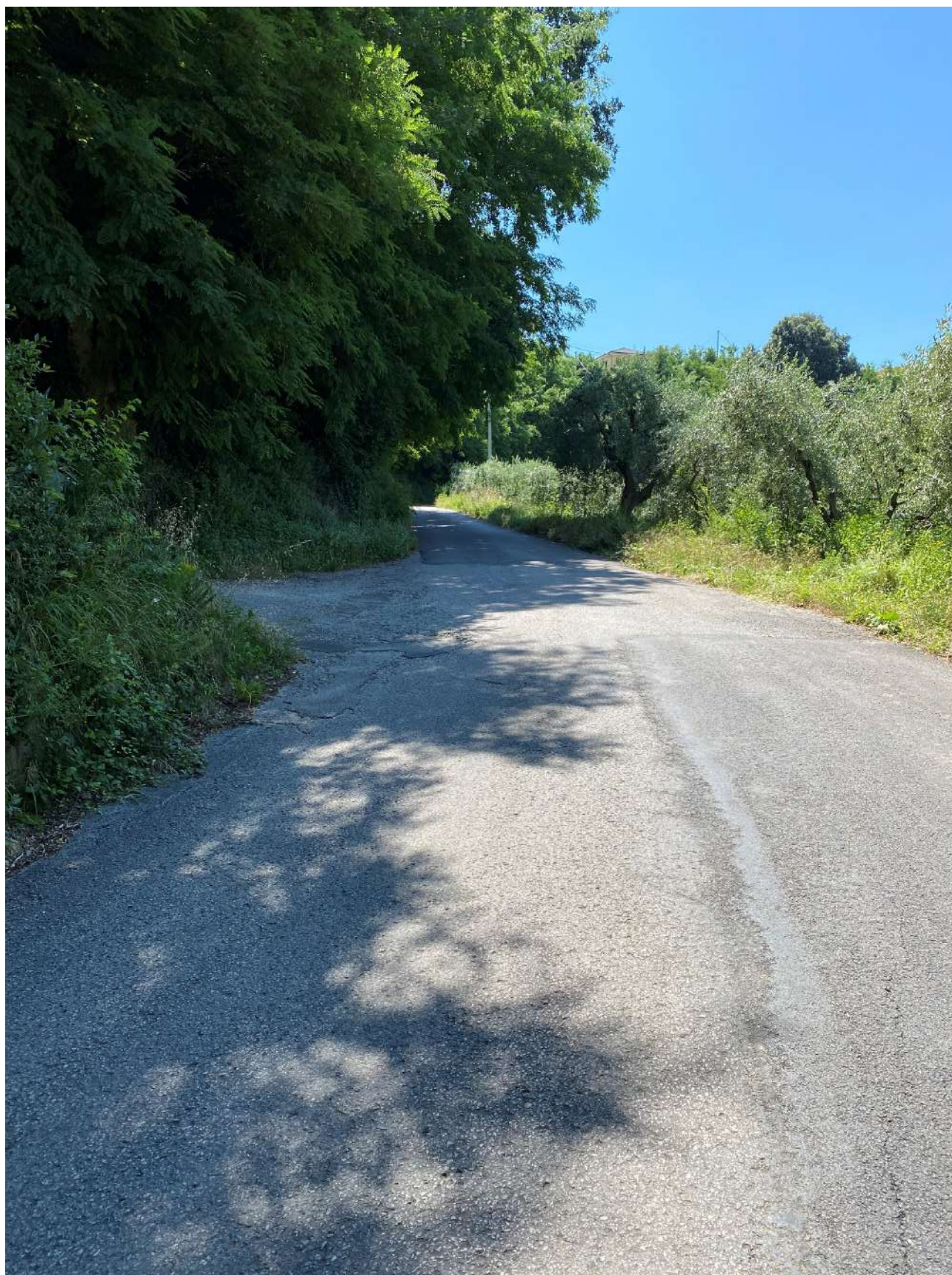
Foto 10 – Sez 4 lato sx
