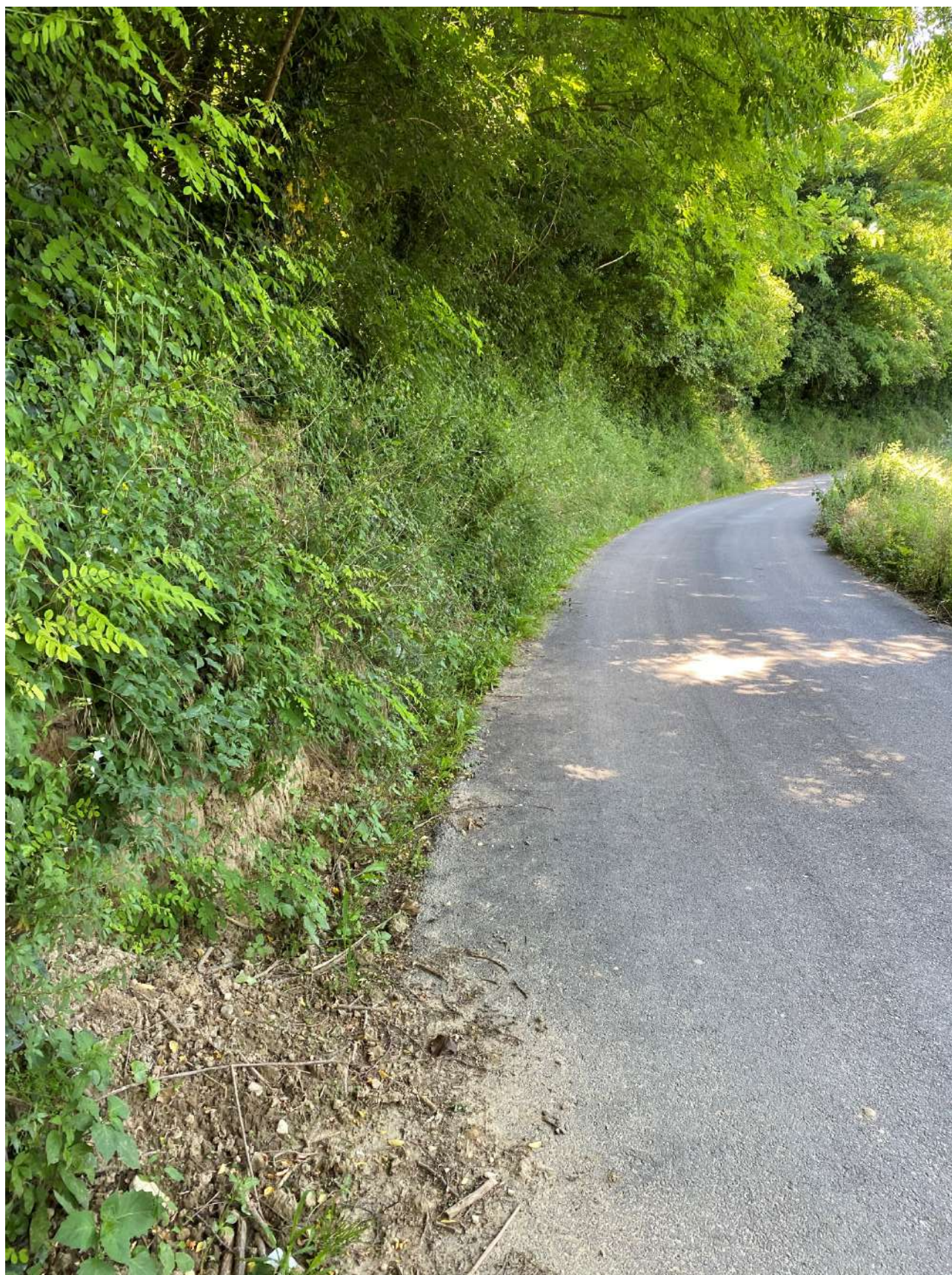
Foto 14 – Sez 6 lato sx
