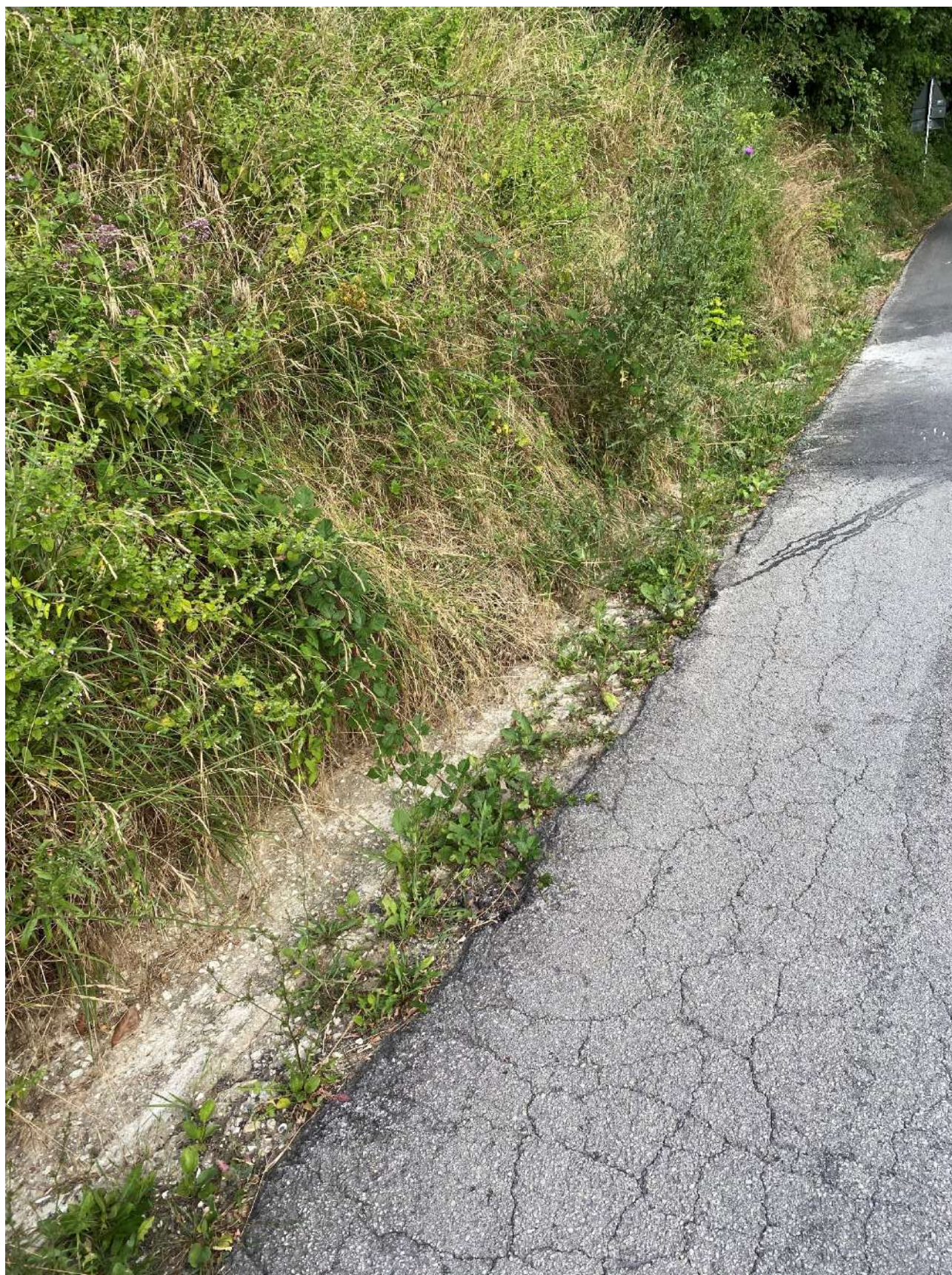
Foto 32 – Realizzazione nuova canaletta in ca
