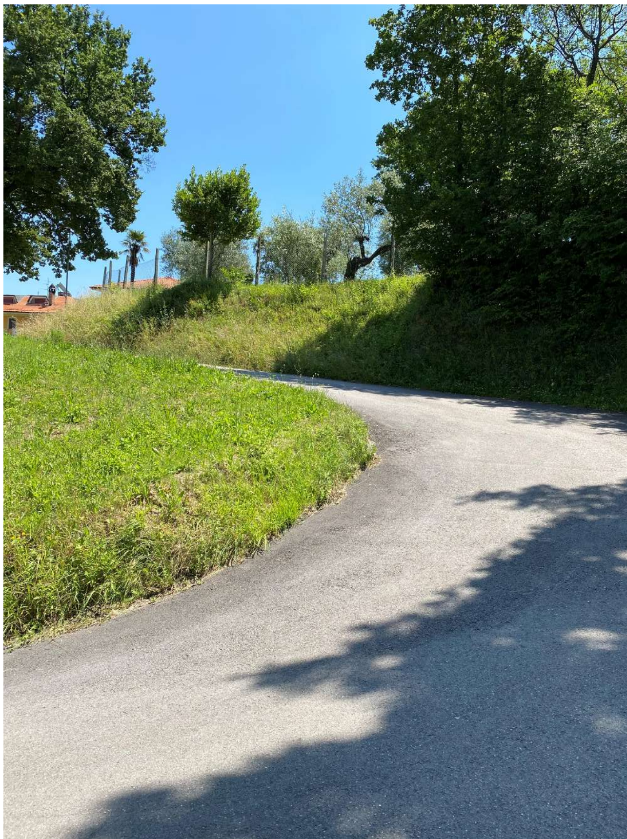
Foto 26 – Sez 12 lato sx
