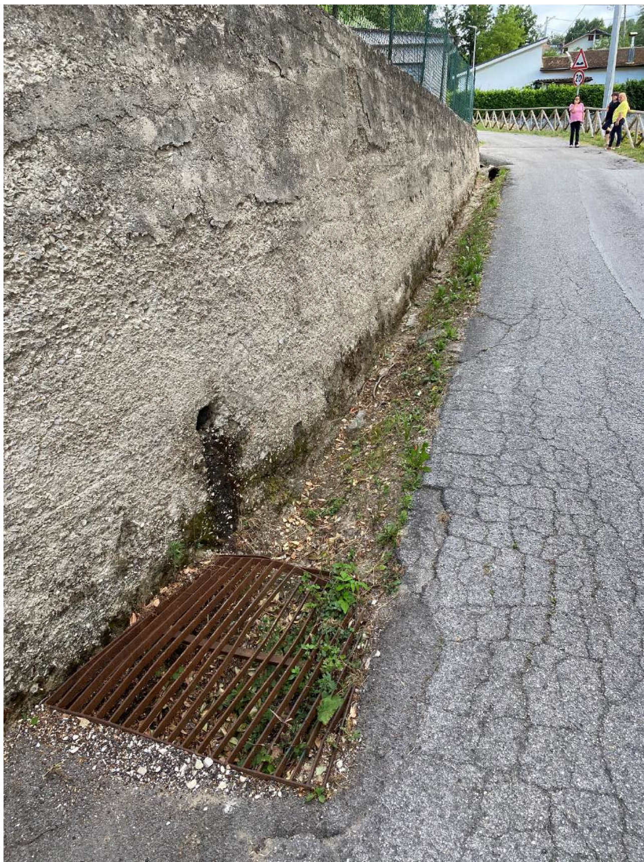
Foto 31 – Realizzazione nuova canaletta in ca
