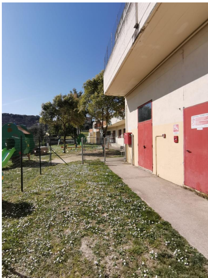
Figura 6 – Esterno piano seminterrato scuola dell'infanzia esistente
