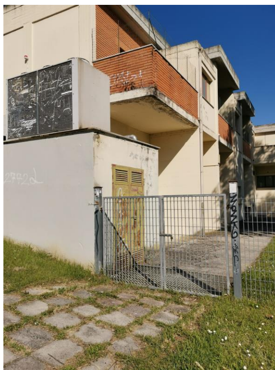
Figura 16 – Lato sud scuola infanzia – scorcio seminterrato
