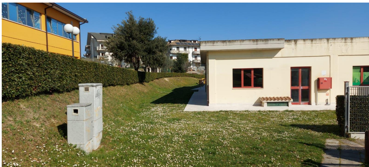
Figura 14 – Lato sud scuola infanzia esistente
