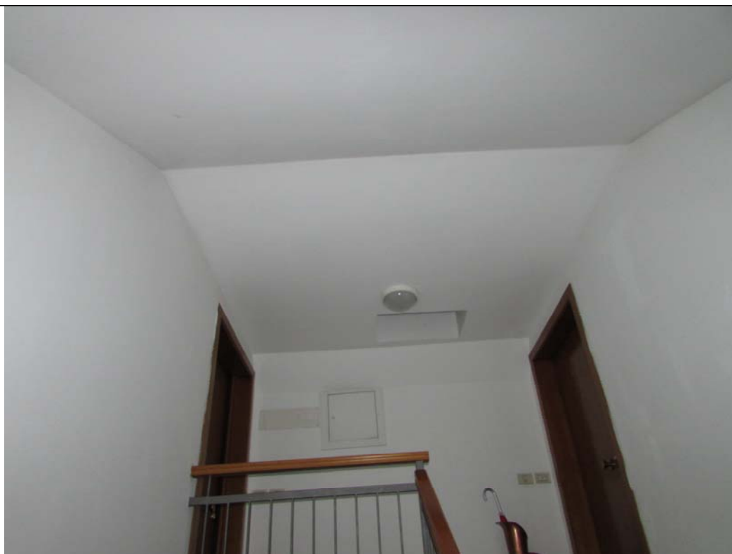
Foto 10: Vano Scala Condominiale Ultimo Piano
