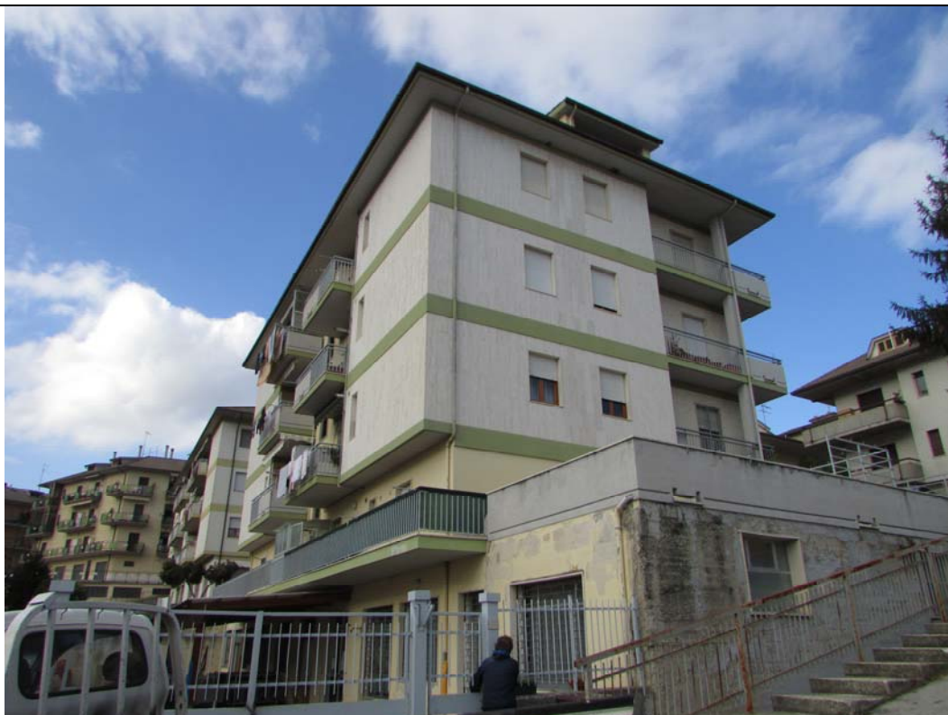
Foto 1: Ingresso Zona Uffici Piano Seminterrato (Lato Nord-Est)
