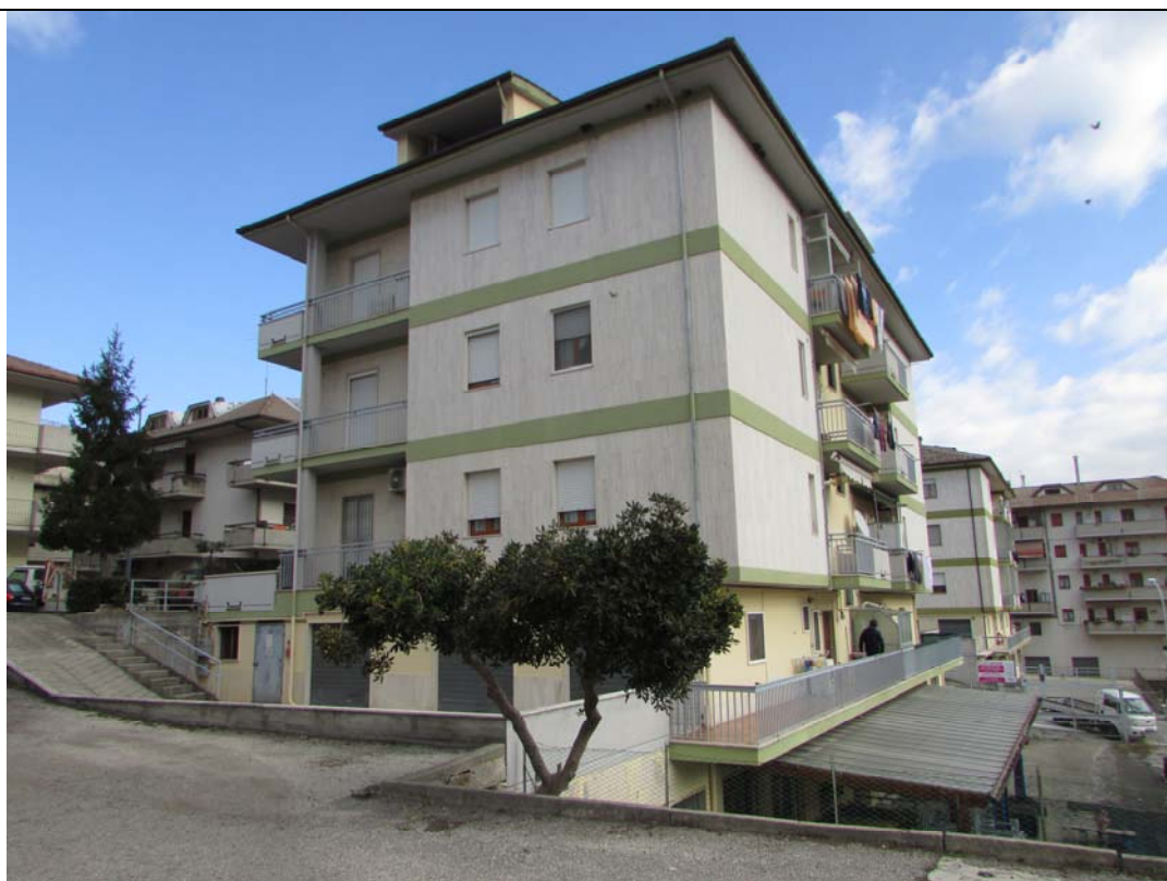
Foto 4 Esterno Lato Sud-Ovest
