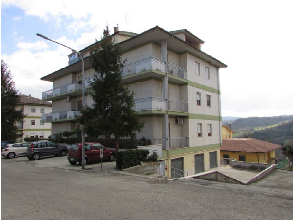
Foto 3 Esterno Lato Nord-Ovest
