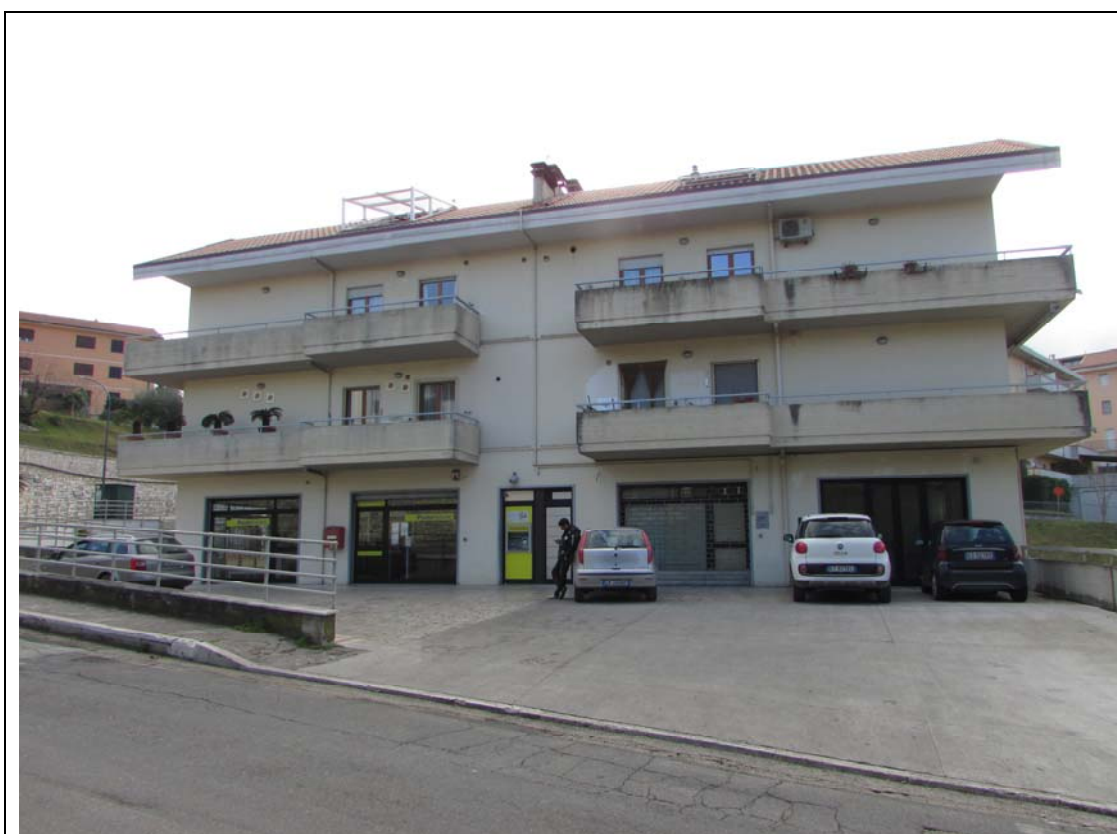
Foto 3: Esterno Lato Nord
