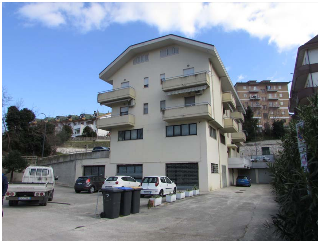
Foto 1: Lato Ovest - Ingresso Magazzino Piano Seminterrato
