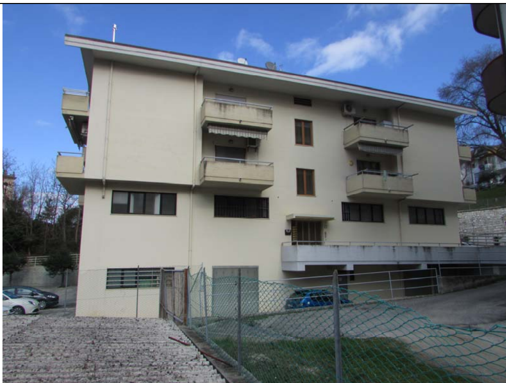
Foto 6: Esterno Lato Sud
