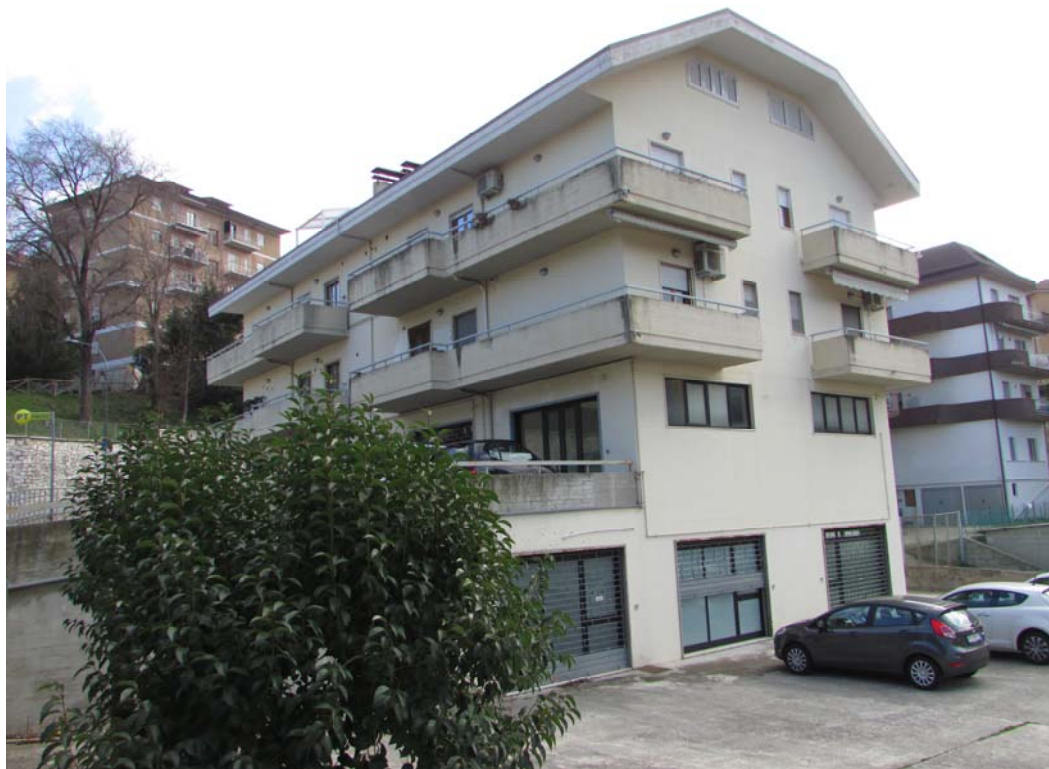
Foto 2 Esterno Lato Nord-Ovest
