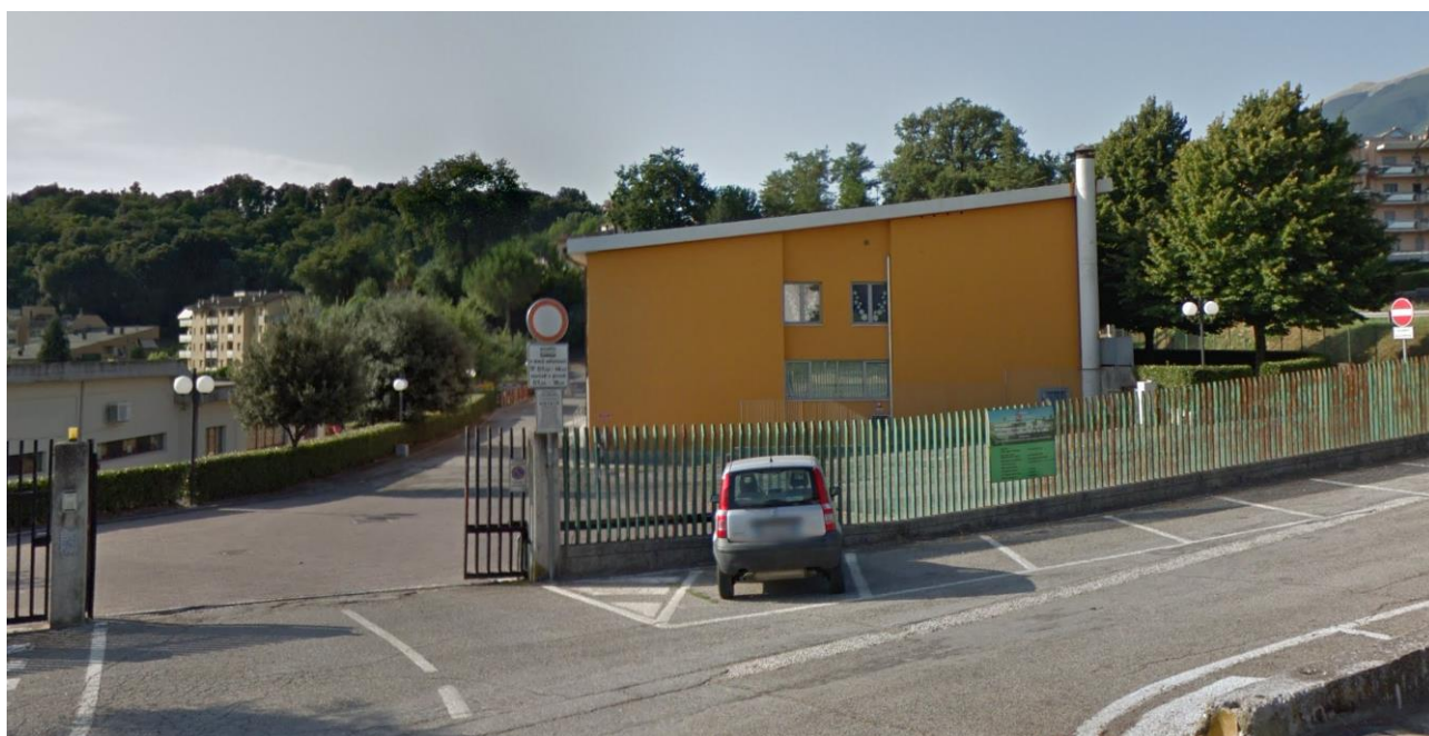
V.2 – p.to di presa fotografico scuola primaria Villa Pigna da via Barbarana
