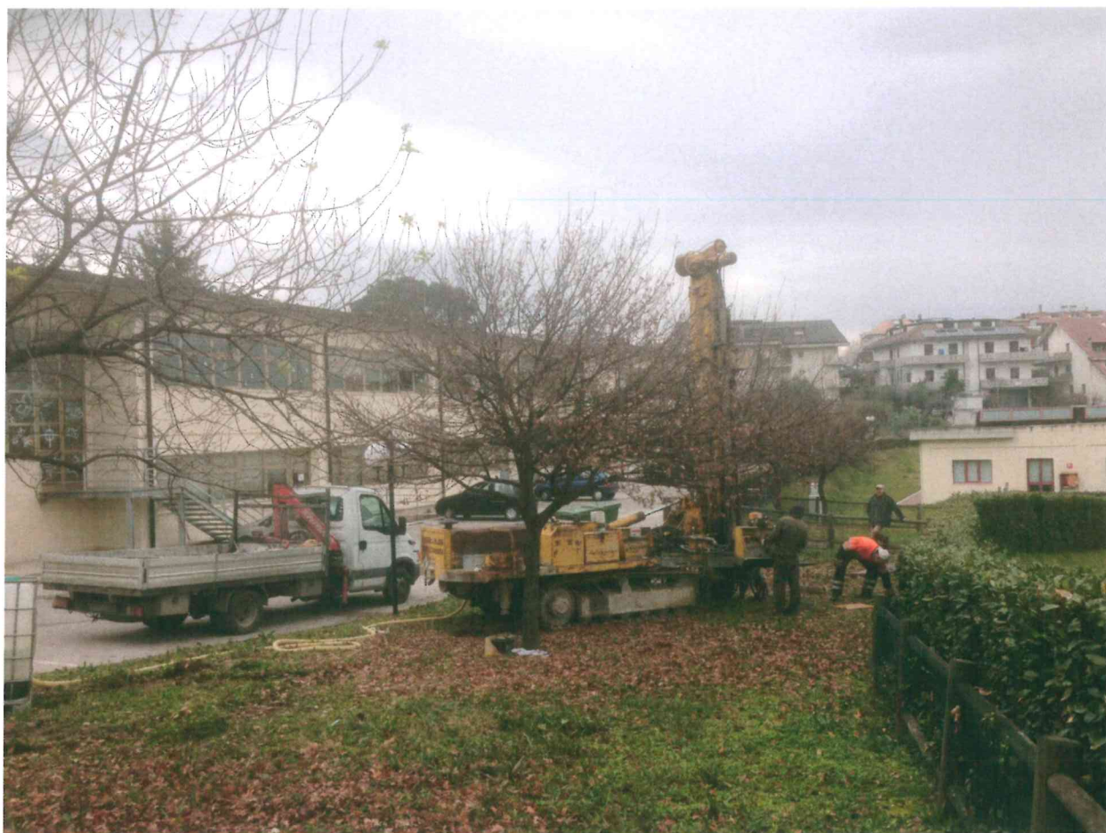
La foto mostra in primo piano l'esecuzione della prova penetrometrica N.1
