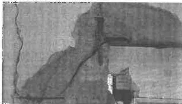
**Figura 2 – Rottura a taglio del nodo al secondo piano della scala sul lato sud-est del fabbricato**
