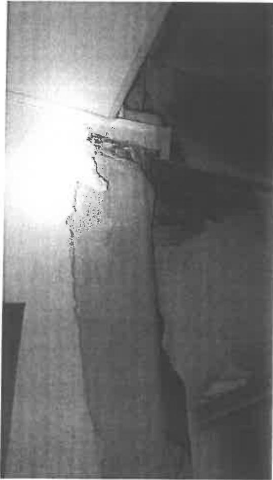
Figura 4 – Risega realizzata in pilastro in c.a. sul lato ovest per la realizzazione di impianti (danno preesistente al sisma)
