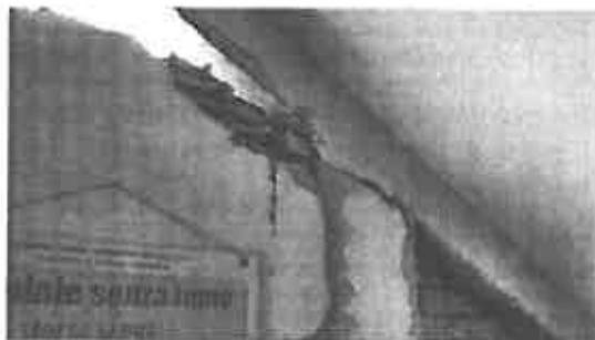
Figura 6 – Rottura del pilastro vano scala in corrispondenza della trave a ginocchio
