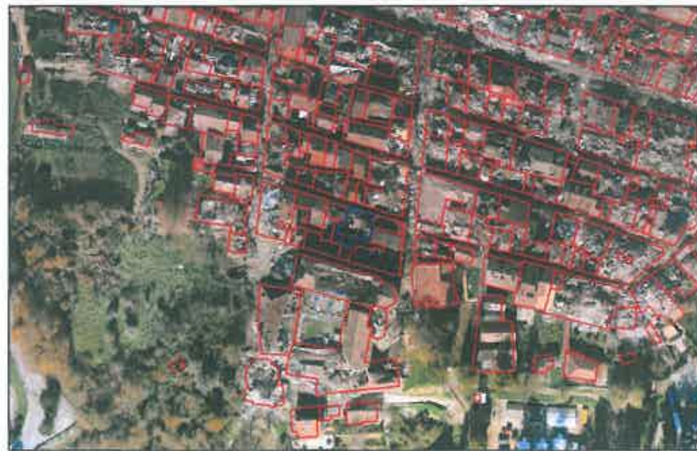
Immagine dopo l'evento sismico del 30/10/2016 (Corpo Nazionale del Vigili del Fuoco).
