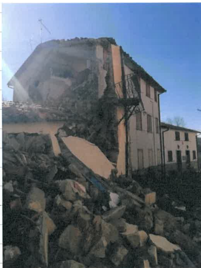
EDIFICIO DISTINTO AL FG. 99 P.LLA 186
