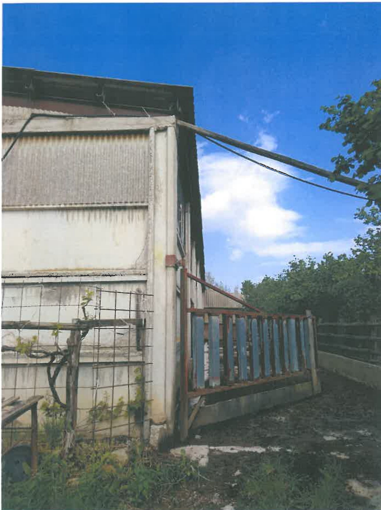
Foto 3 – Fuori piombo pilastri Stalla inagibile
