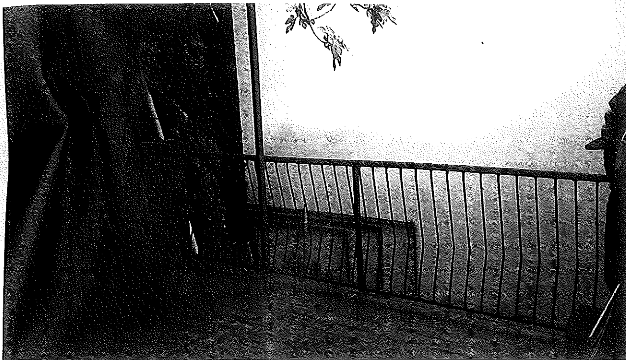
Prospetto di terrazzo sconfinante su proprietà Comunale
