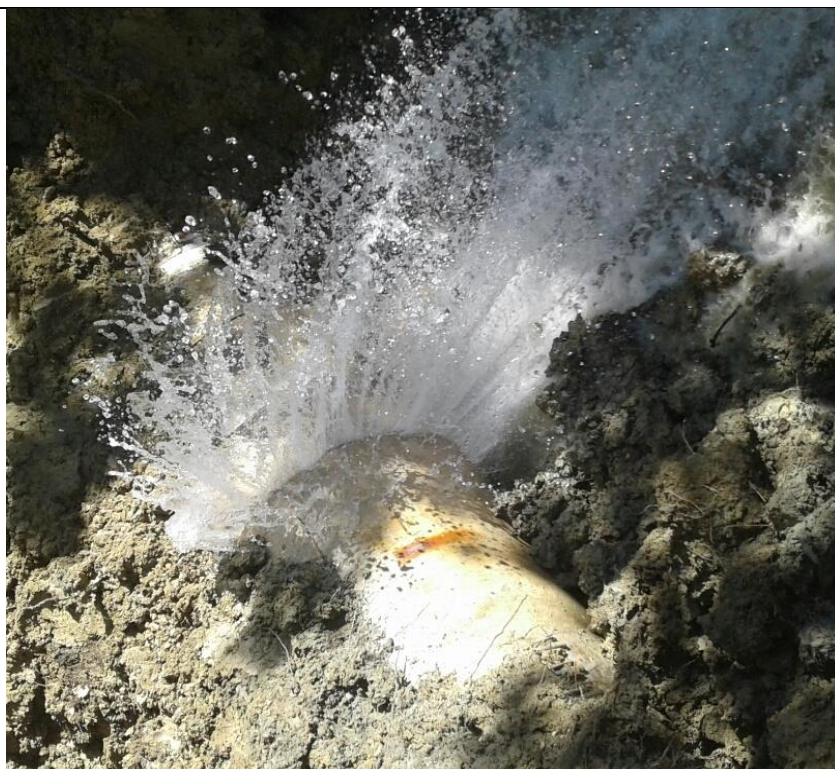
Sisma 2016: Rottura condotta Acquedotto Pescara
