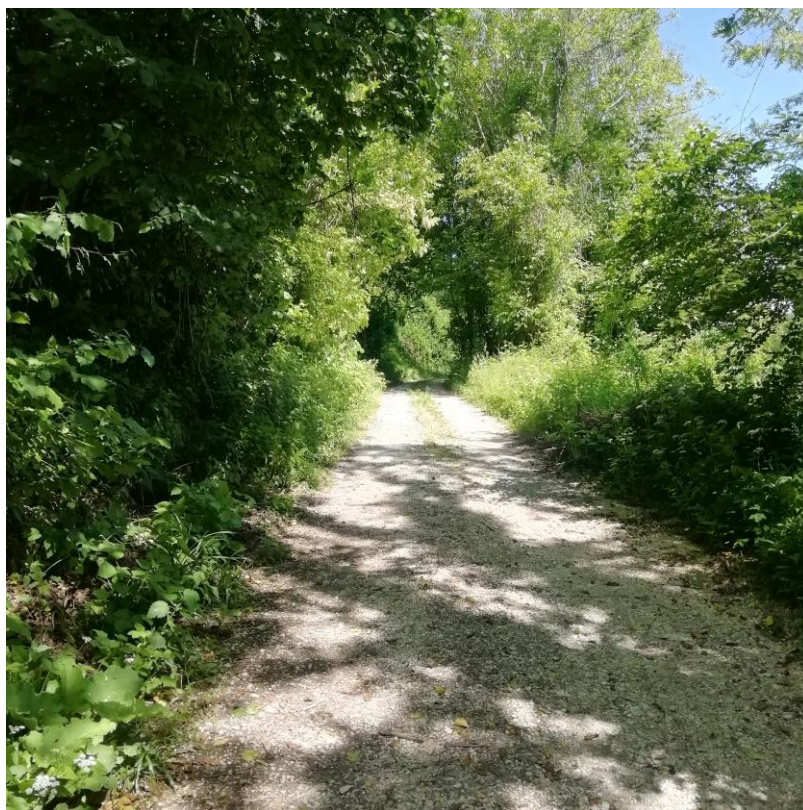
Scatto 6: Vista della nuova strada vicinale di Quadra (p.lla 576 Foglio 50) prospiciente la p.lla 38 Foglio 50.
