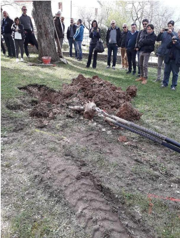
Fissata la testa di alesaggio e la tubazione/i oggetto di posa si avvia l'ultima fase di alesaggio con conseguente tiro/traino della tubazione oggetto di posa.
