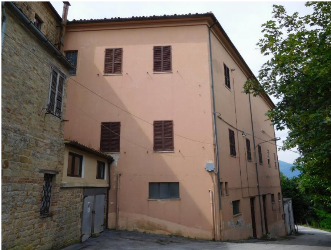
Foto 4: fronte su via della Circonvallazione, da monte
