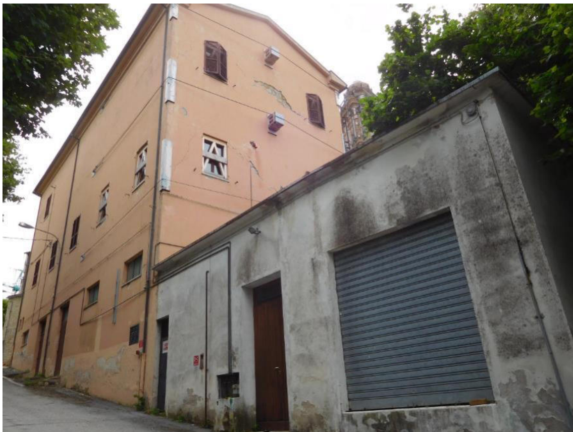
Foto n. 1: prospetto su via della Circonvallazione, da valle
