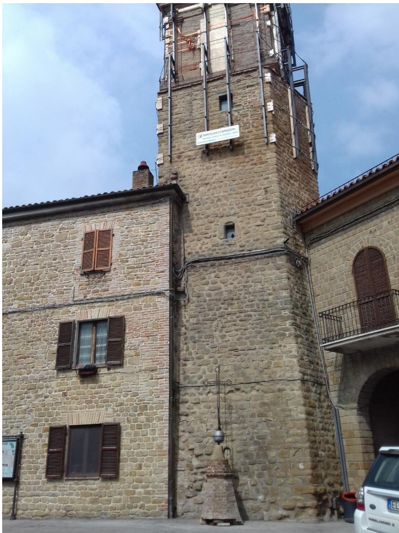
Foto 8: base torre con pennacchio smontato
