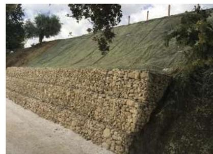
Realizzazione di gabbionate per il consolidamento del versante Montecalvo SC3
