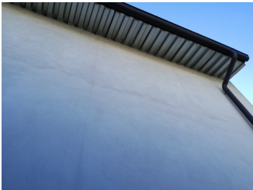
Vista 3 Prospetto Ovest
