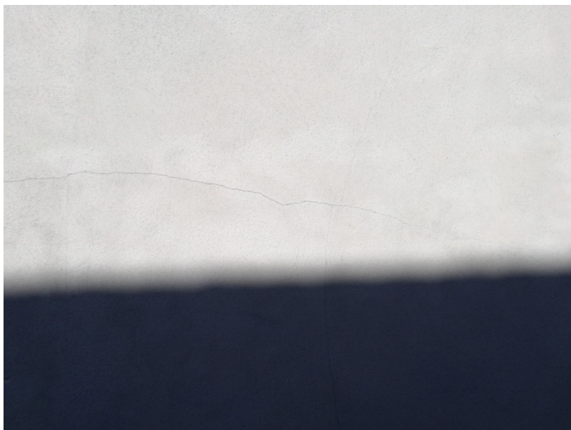
Vista 5 Prospetto Est
