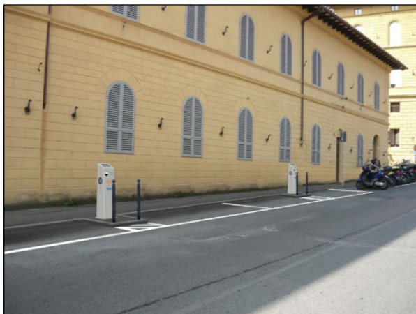
Esempio di installazione di infrastrutture di ricarica su marciapiede esistente e su strada con area rialzata e dissuasori
