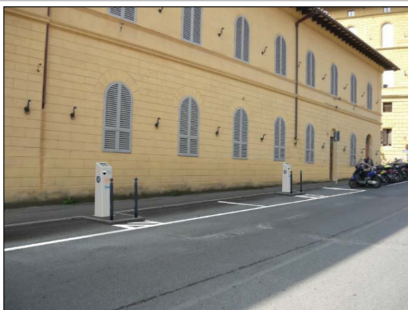
Esempio di installazione di infrastrutture di ricarica su marciapiede esistente e su strada con area rialzata e dissuasori
