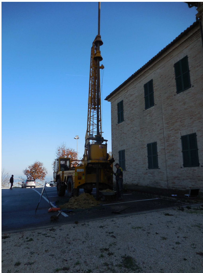
Foto 1. Macchina perforatrice durante il sondaggio S1.
