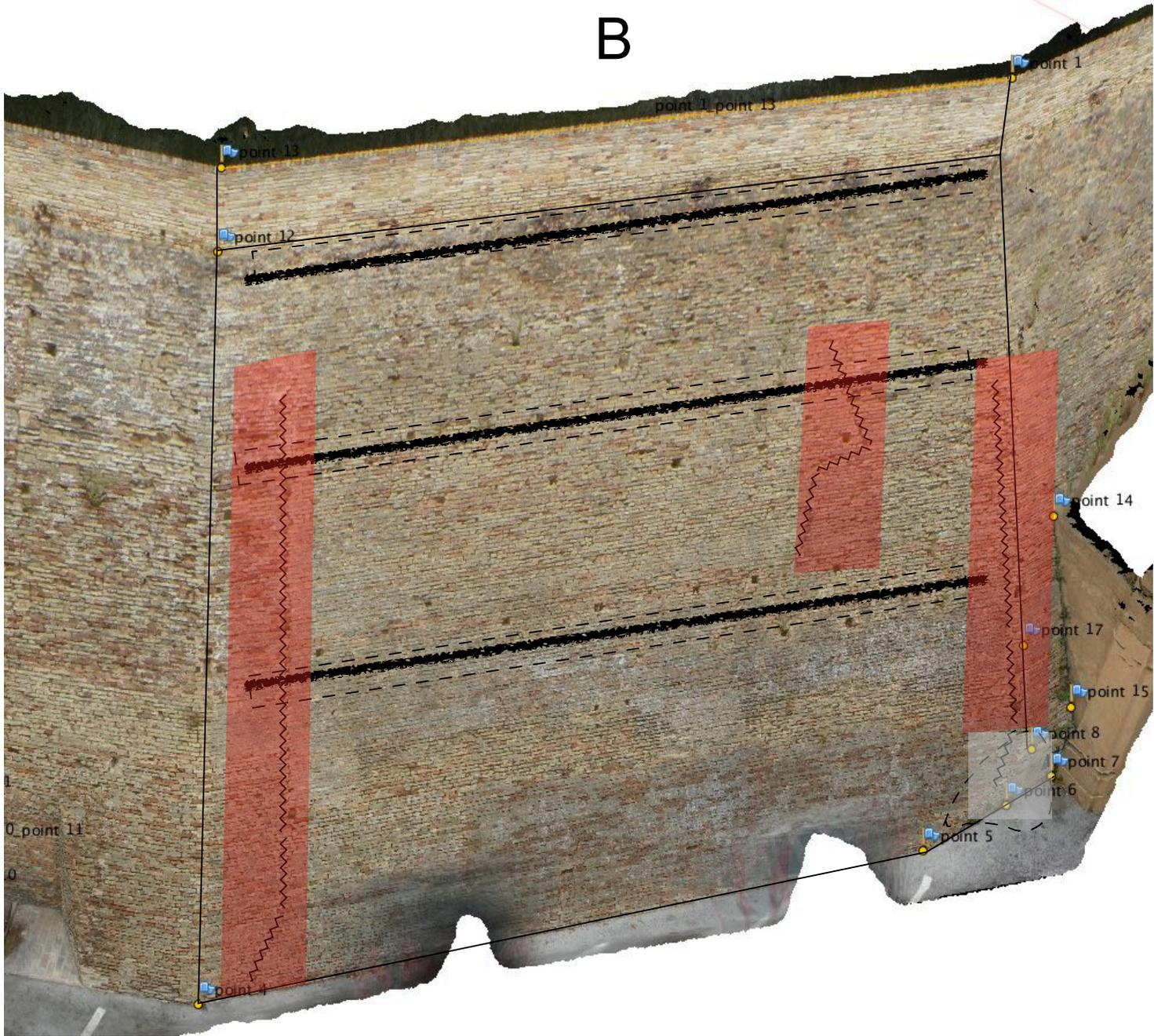
crollo della cortina muraria esterna, con varie sconessioni e allargamento della porzione cortina che si sta sfaldando. Possibili cause dovute alla mancanza dei fori di uscita dell'acqua
