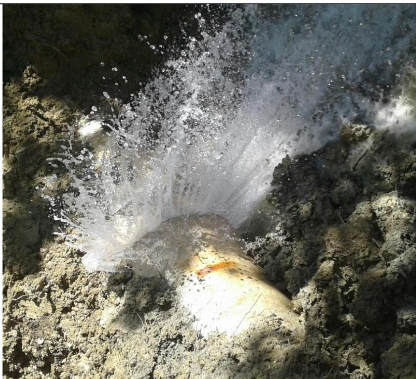
Sisma 2016: Rottura condotta Acquedotto Pescara
