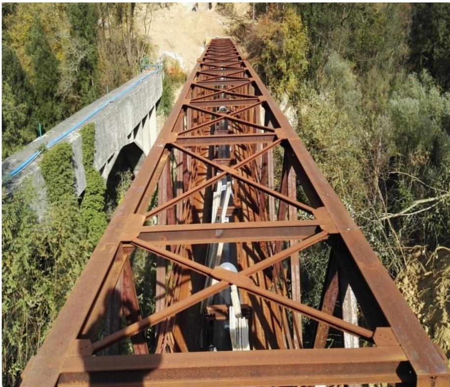
La progettazione dell'intervento sul Ponte Marese, stante le notevoli difficoltà cantieristiche di intervento sul ponte tubo esistente, essendo particolarmente inciso l'alveo del torrente Fluvione nel punto di attraversamento, ha previsto la costruzione "ex novo" dell'attraversamento acquedottistico del torrente Fluvione tramite la realizzazione
