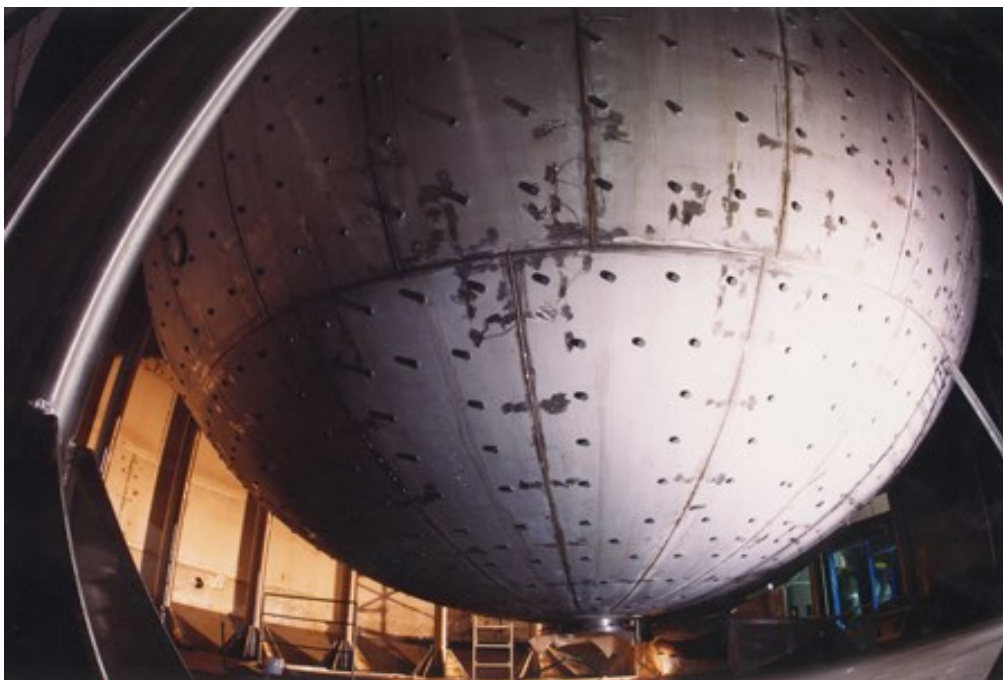
Figura 36 – Esperimento Borexino, fase di costruzione all'interno della Water Tank con vista della SSS Stainless Steel Sphere in acciaio inox contenente pseudocumene.
