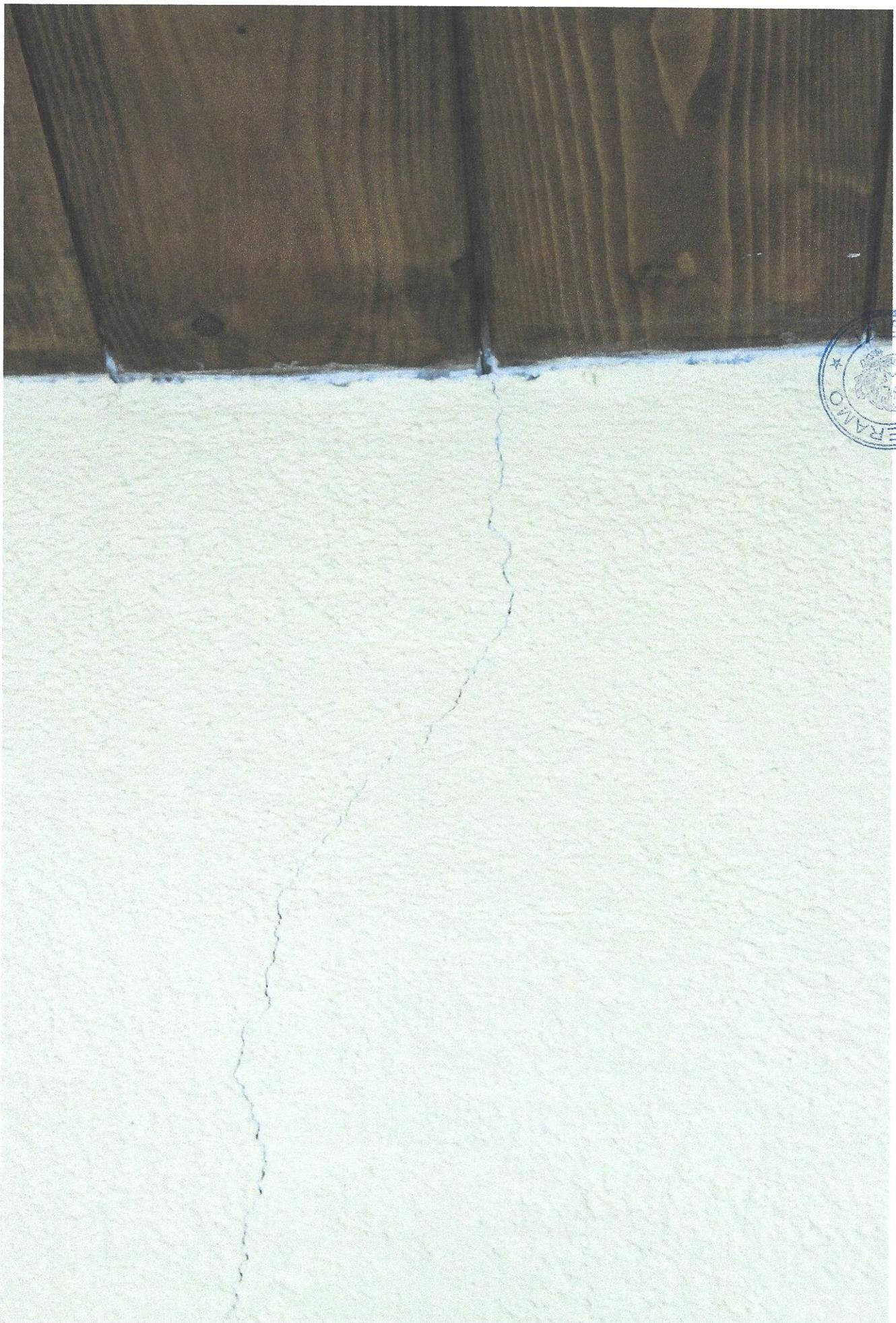
Fig.8 – Sottile lesione interna verticale sulla parete Sud (in comune con la proprietà Ciarma Attilio) nel vano pranzo al piano primo
