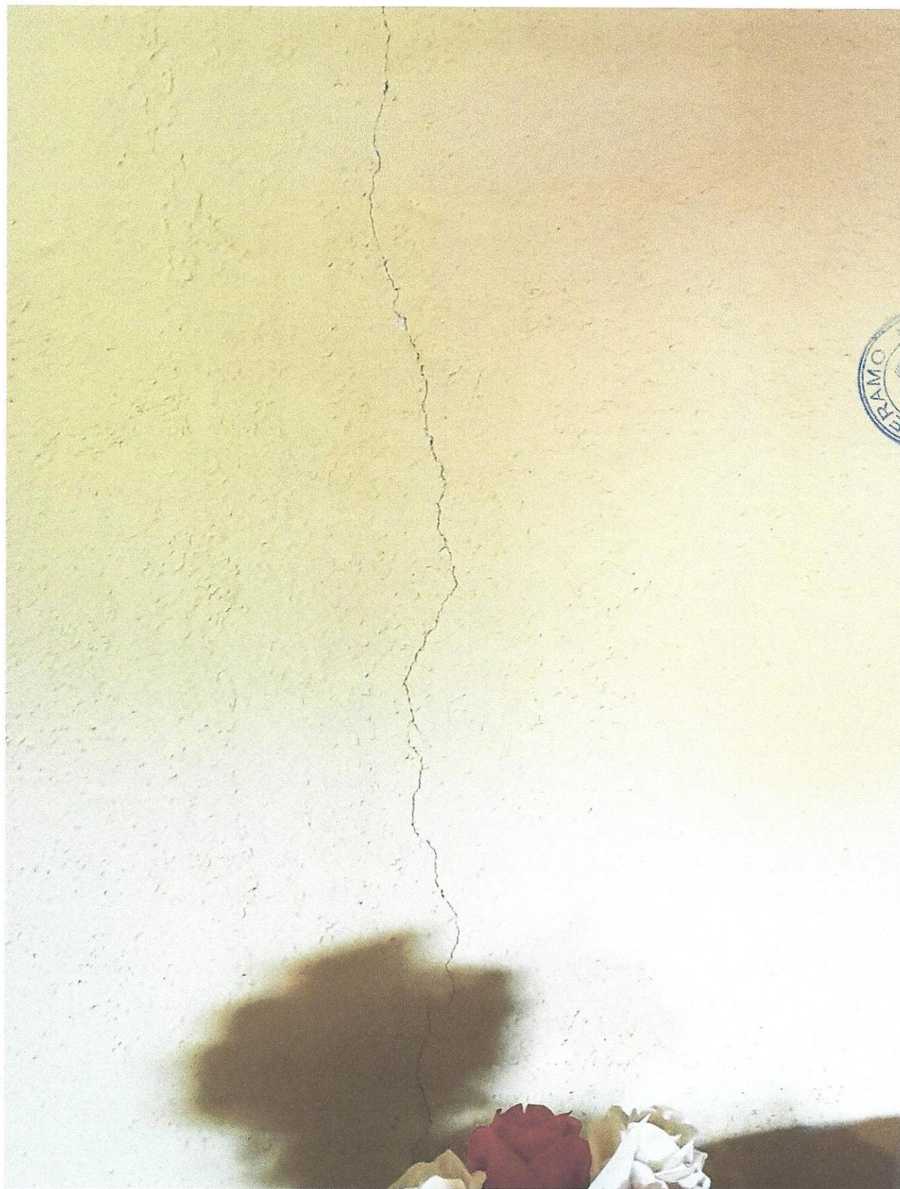
Fig.6 - Lesione interna verticale sulla parete Ovest nel vano camera da letto al piano superiore
