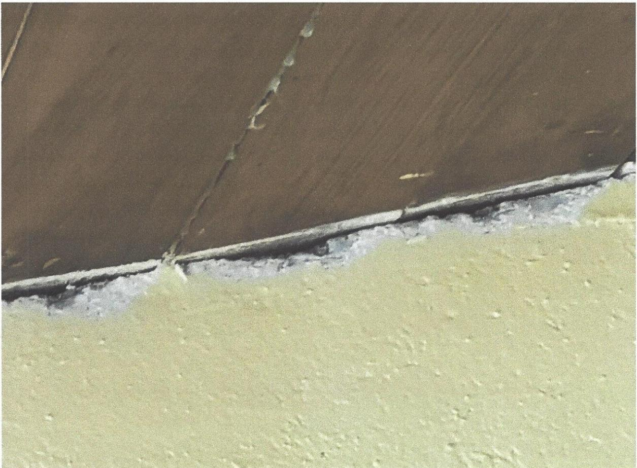
Fig.5 – Ulteriori distacchi di intonaco in corrispondenza del tavolato di copertura
