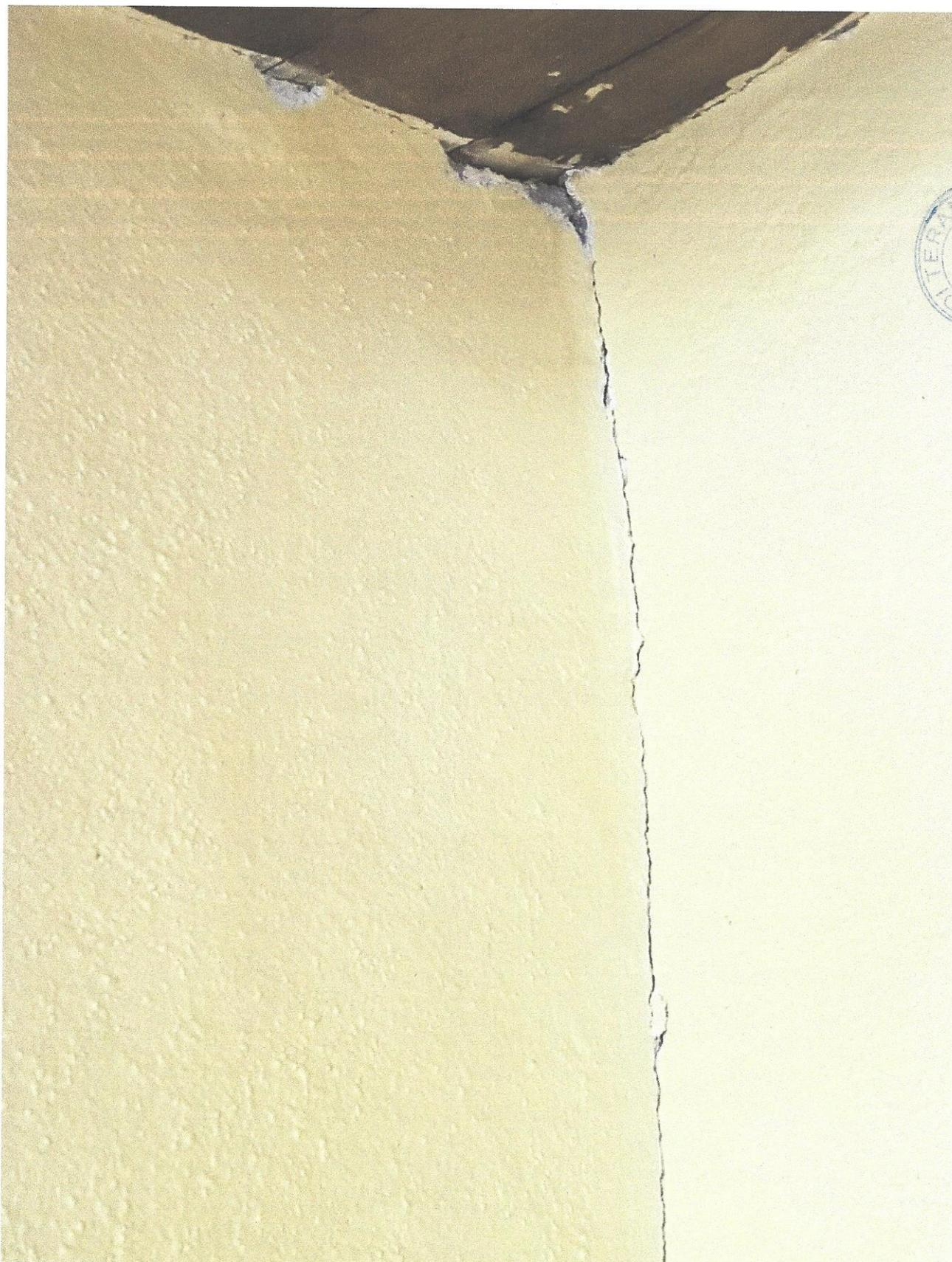
**Fig.1 - Lesione interna verticale d'angolo nel vano camera da letto al piano superiore - spigolo Sud-Ovest, inquadrata in alto, in corrispondenza dell'intradosso del tavolato di copertura**
