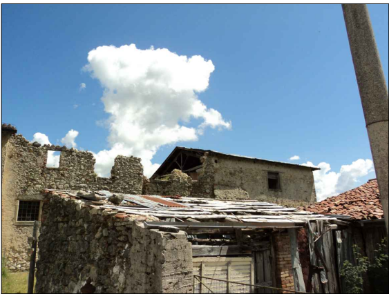
Foto della copertura lato sud-est
