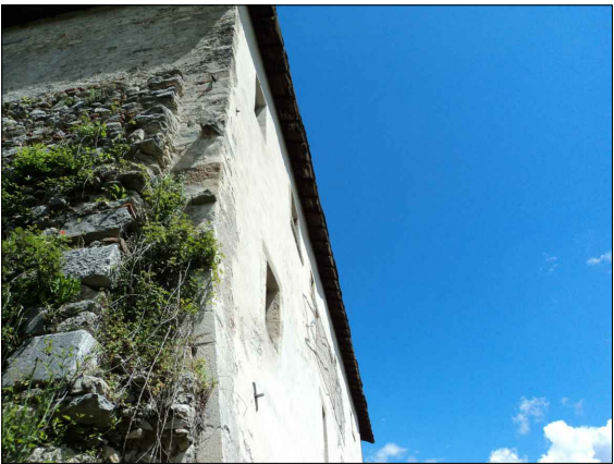
Foto della gronda sulla facciata frontale
