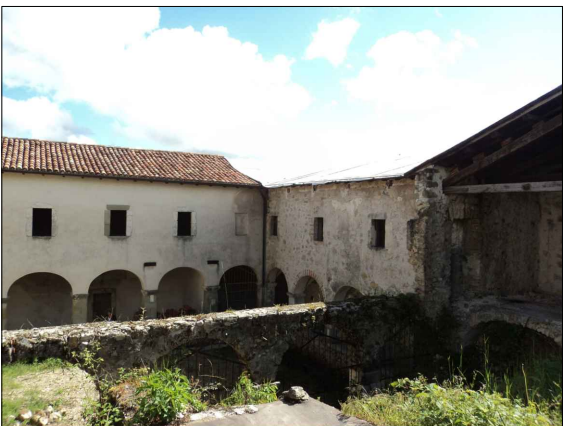
Foto della copertura dall'interno del chiostro
