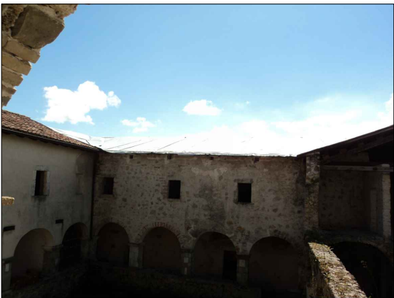
Foto della copertura dall'interno del chiostro
