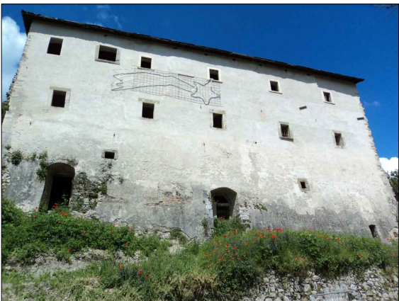
Foto della facciata fronte strada
