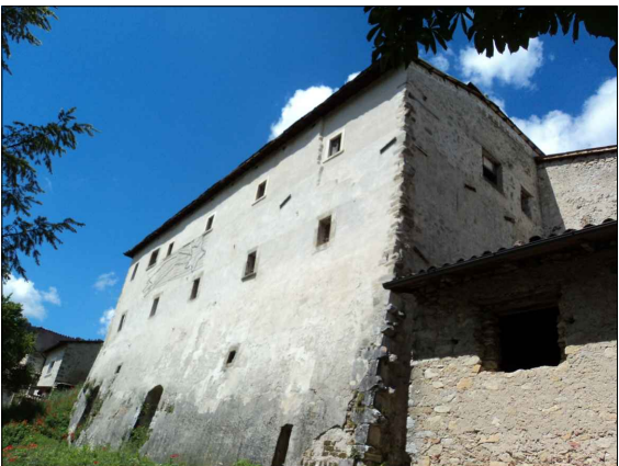
Foto della facciata fronte strada
