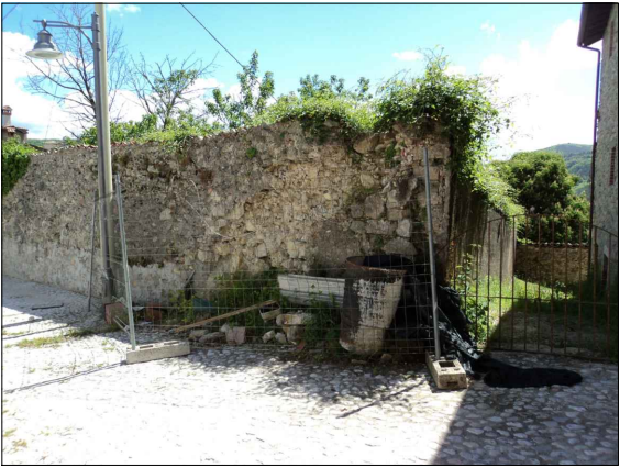
Foto della porzione di muro da demolire
