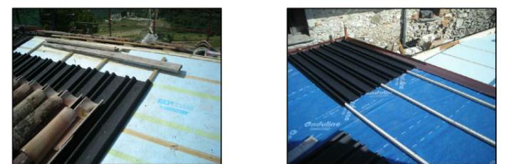
2. Posizionare la griglia lungo la linea di gronda, con una spaziatura all'interno della stessa di circa 5 cm e bloccarla con il fissaggio meccanico. Attenzione di procedere con la griglia successivamente è consigliato posizionare la rispettiva fascia anticorrosione per verificare la corretta corrispondenza con il passo delle onde.
