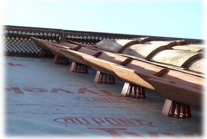
La griglia di partenza parapasseri permette un ingresso d'aria dalla linea di gronda pari a 400 cm<sup>2</sup>/m. L'ingresso dell'aria avviene sopra la gronda e sarà
