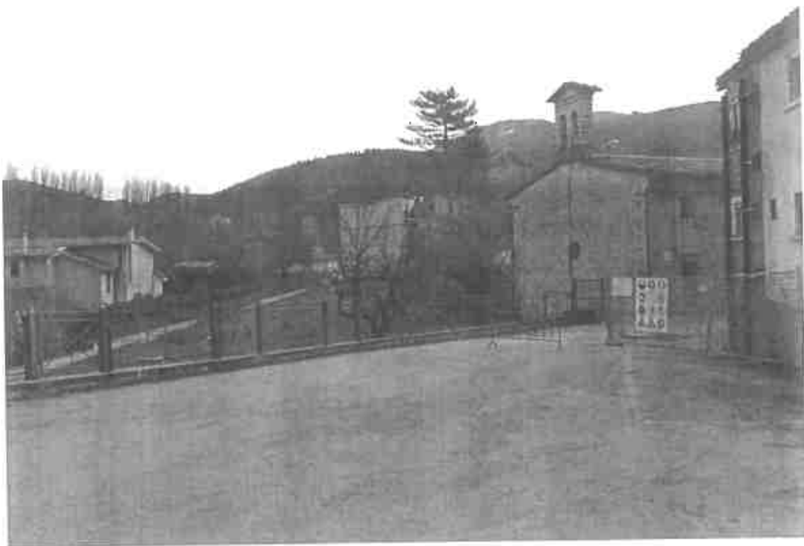
Foto n. 2 accesso alla passerella da via san Giuseppe, il dislivello è di circa 1.80 mt
