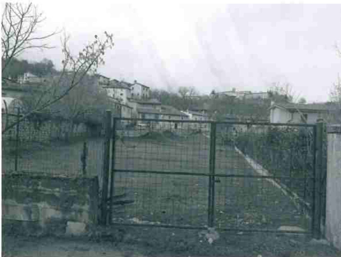
Foto n. 3 tratto finale dell'intervento su via Flume.
