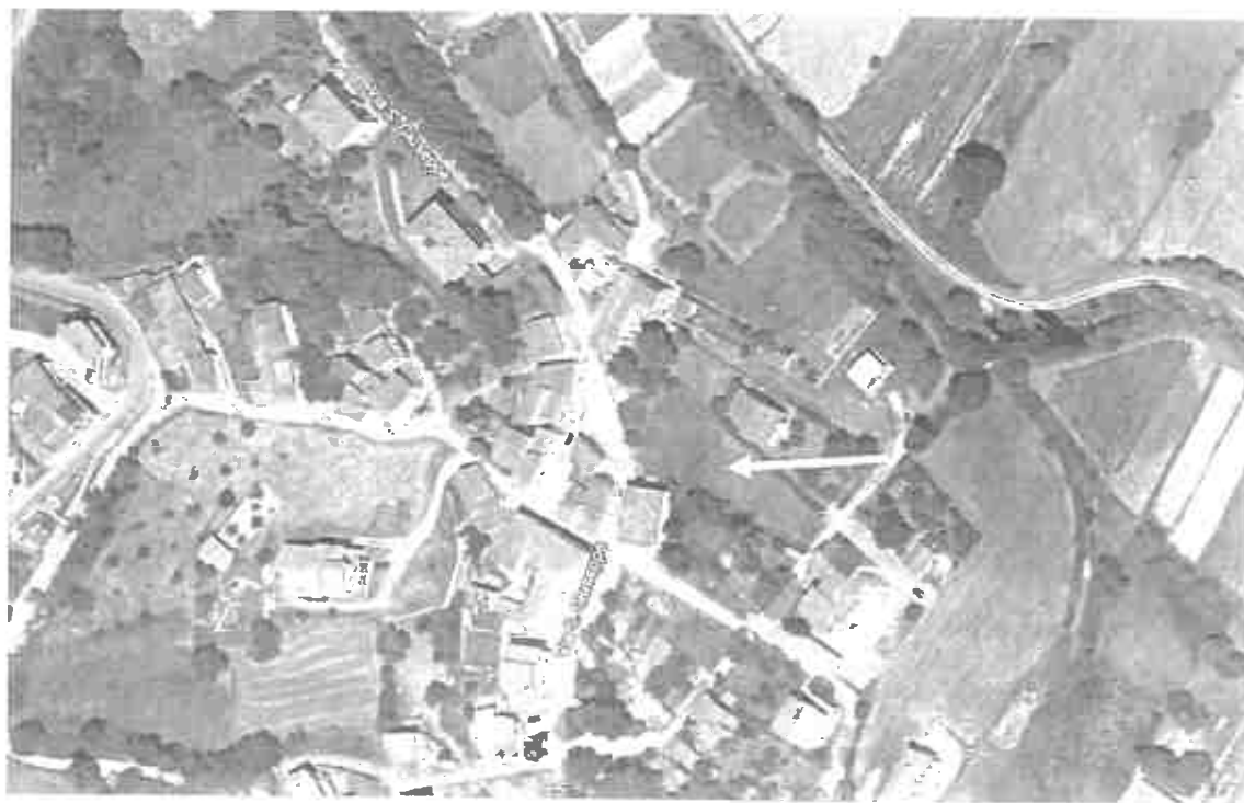
Foto n. 1 vista aerea con indicazione dell'area di intervento
