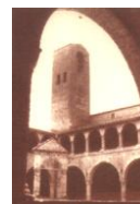
S.M. PROPEZZANO "Chiostro"
