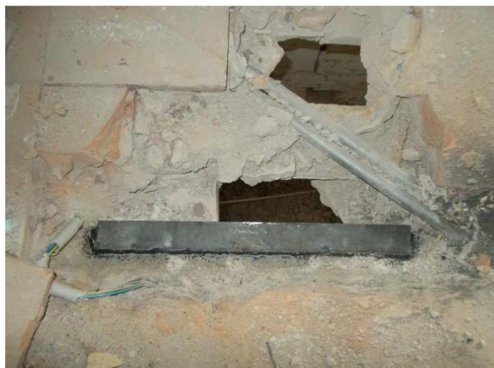
**Foto 2 – Piano primo.** Campione di acciaio ripristinato mediante saldatura
