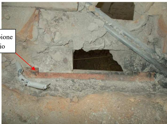
**Foto 1 – Piano Primo.** Prelievo di un campione di acciaio da un profilato costituente un elemento portante il solaio del piano primo
