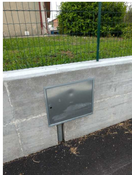
Foto 4 - particolare spostamento contatore gas
