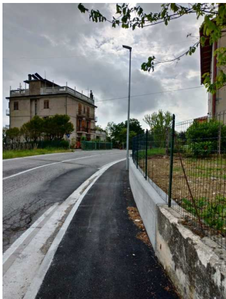
Foto 3 - particolare nuovo palo illuminazione
