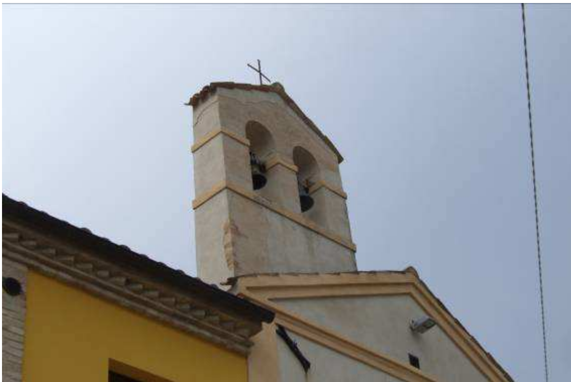
Foto 1 - posizione vela campanaria in prossimità dell'abitazione privata
