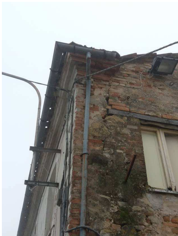
Particolari spigoli danneggiati angoli Nord-Est (Via Dante – Monte) e Sud Est (Via Dante – Valle)
