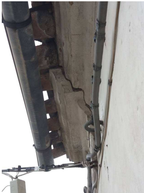
Particolari spigoli danneggiati angoli Nord-Est (Via Dante – Monte) e Sud Est (Via Dante – Valle)
