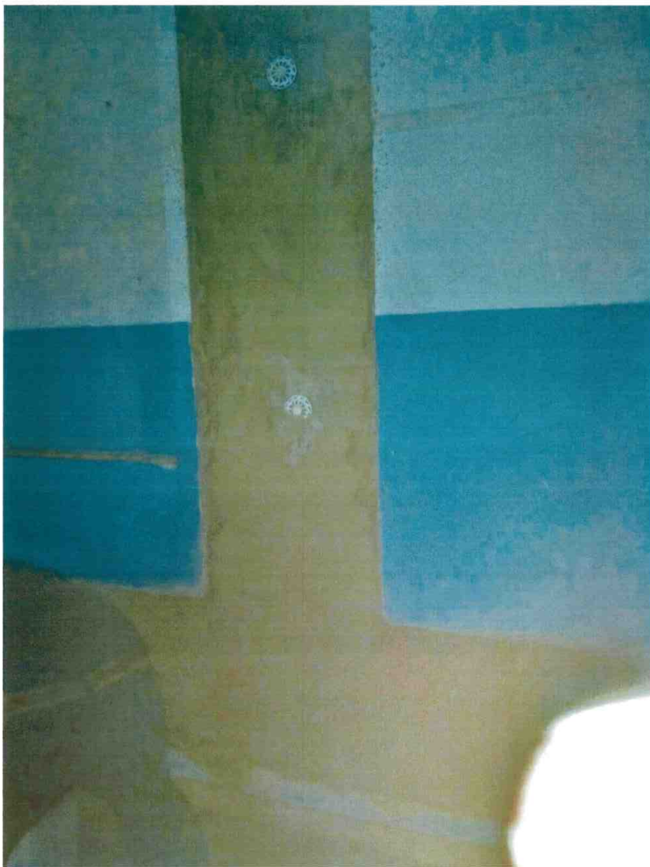
FASE 4 – Stesura secondo strato di Geomalta ed affogamento dei connettori nella malta
