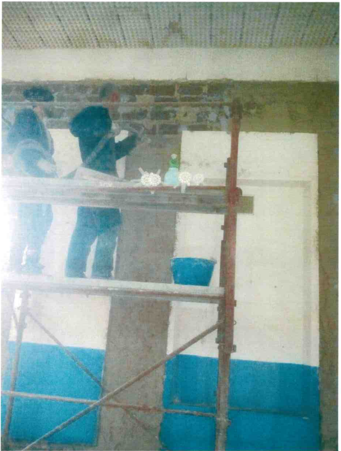
FASE 2 – Stesura primo strato di Geomalta con realizzazione di fori per connettori
