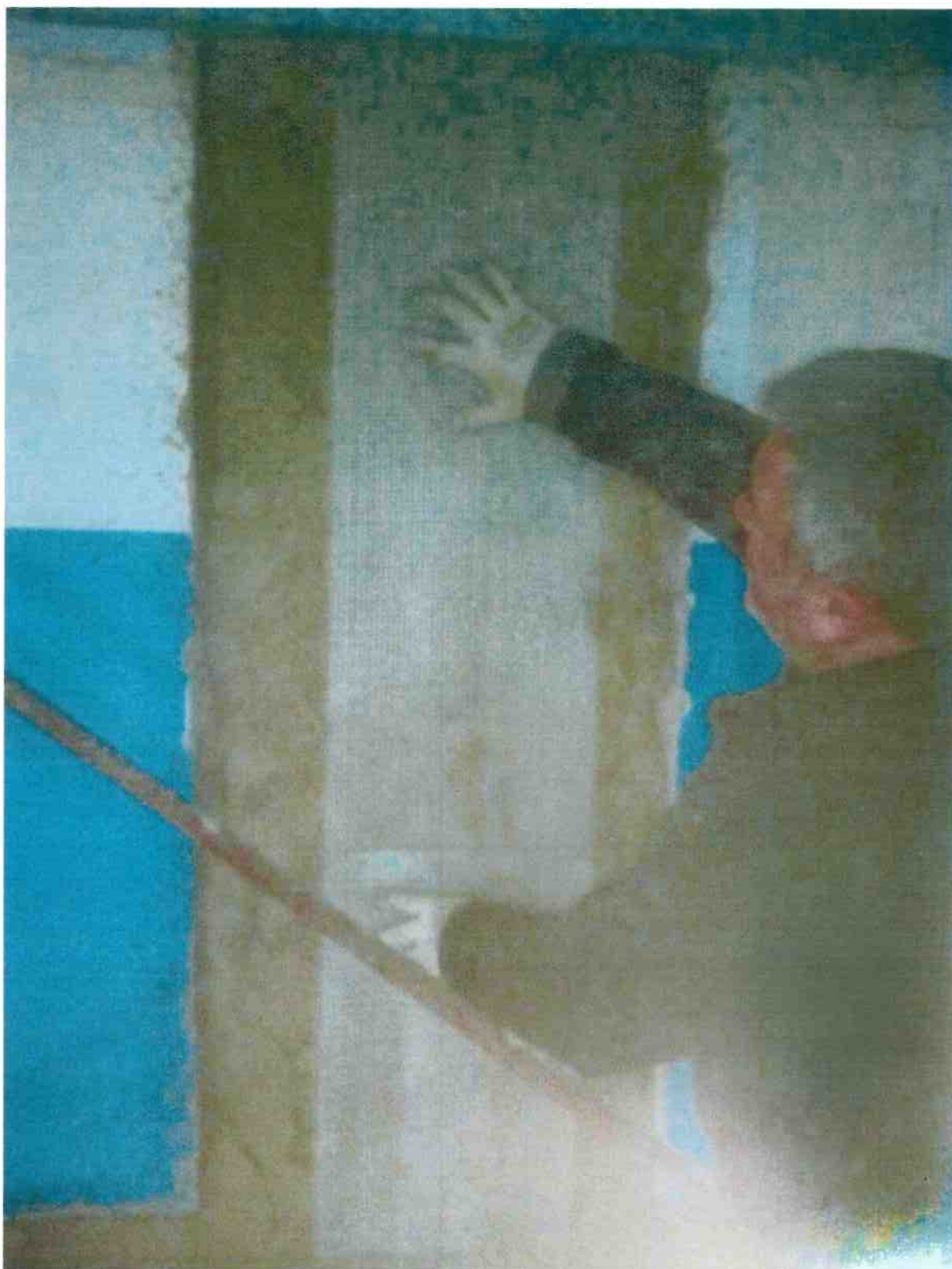
FASE 3 – posa in opera di fibra di basalto e acciaio Inox e connettori
