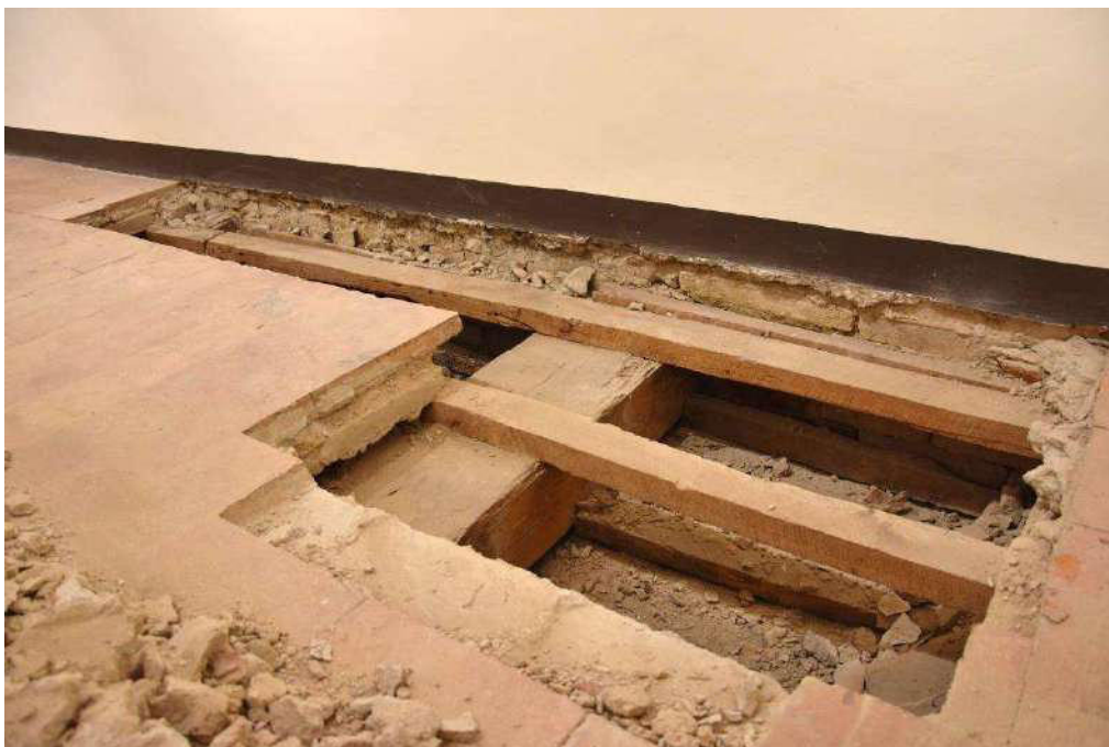
Fig. 15 - Dettaglio solaio.
