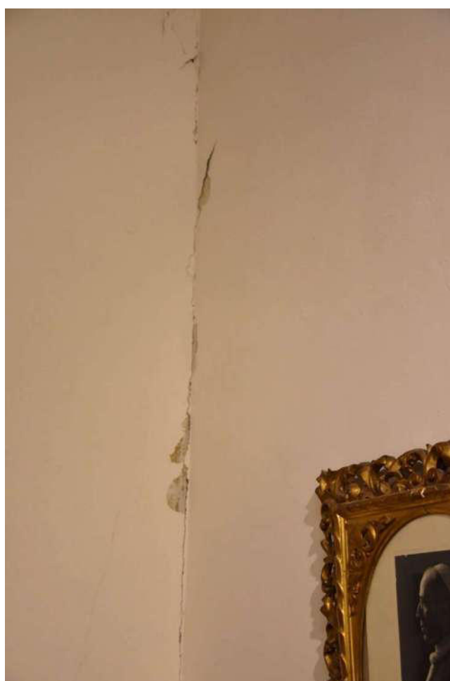
Fig. 10 – Particolare Fessura.
