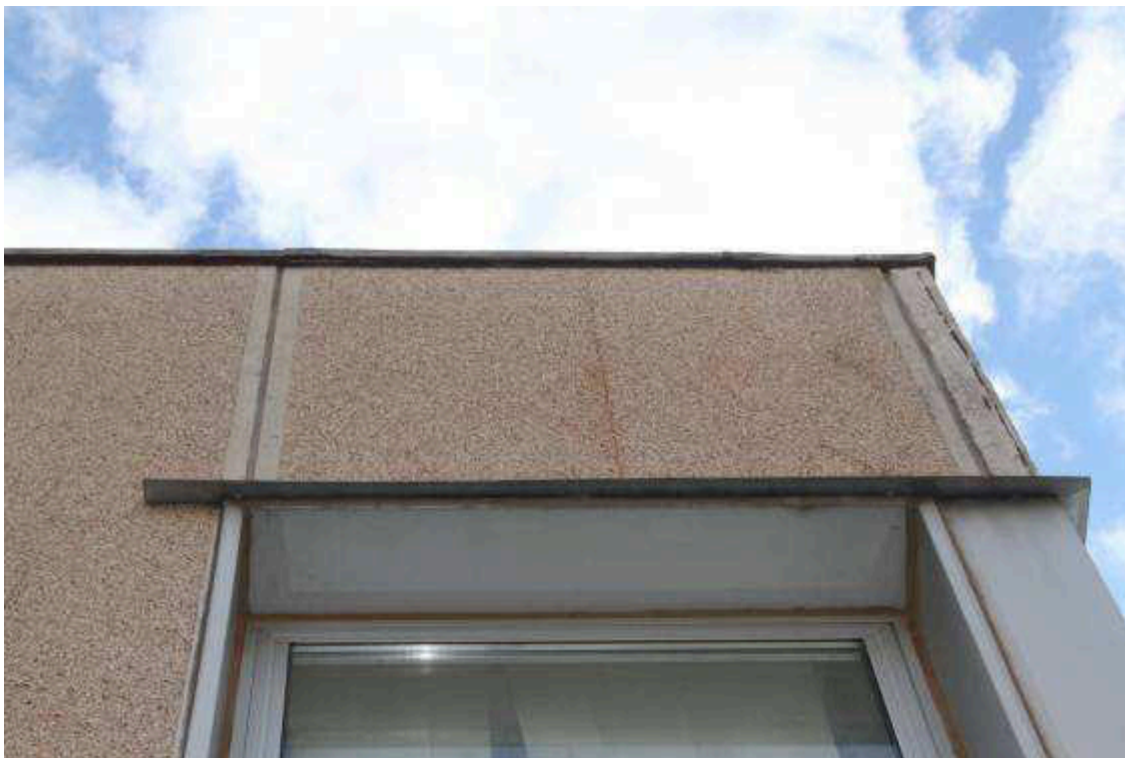
FIG.9: Vista particolare scossaline in lamiera.
