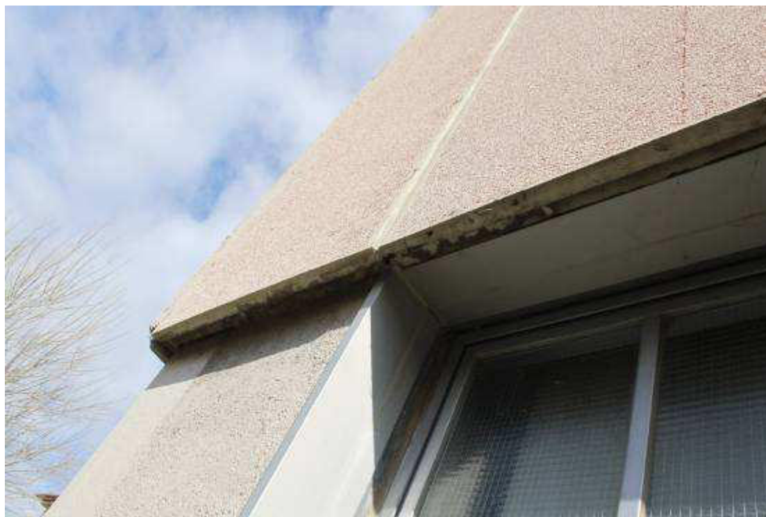
FIG.8: Vista del particolare rientranza di facciata nei prospetti Nord ed Ovest.
