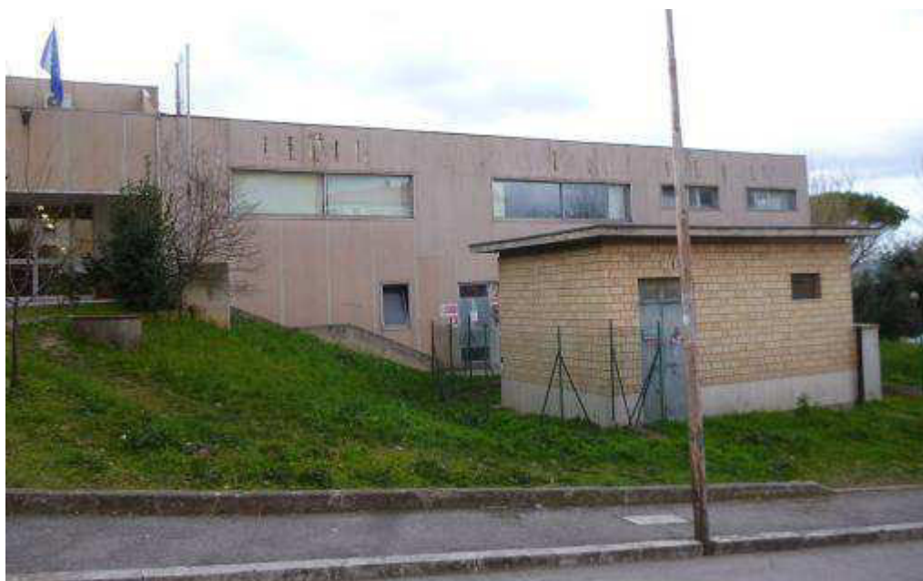
FIG.2: Vista lato Nord
