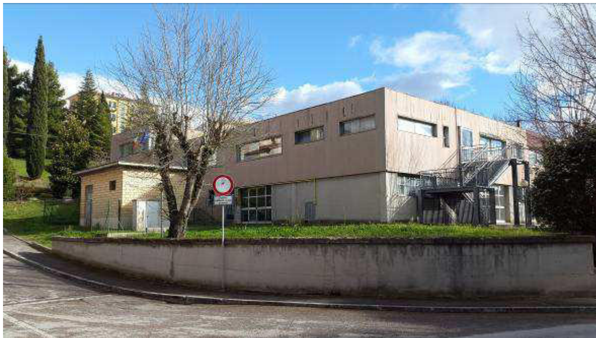
FIG.3: Vista lato Nord-ovest
