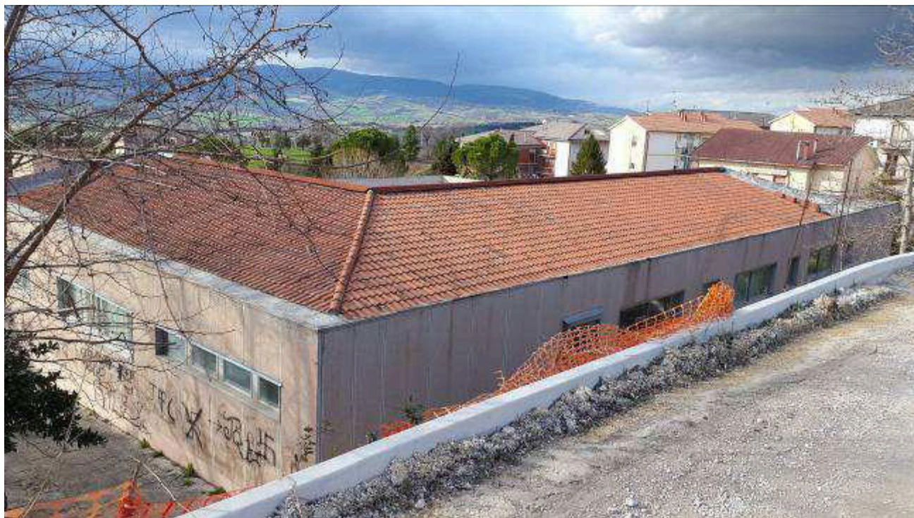
FIG.4: Vista copertura lato sud-est
