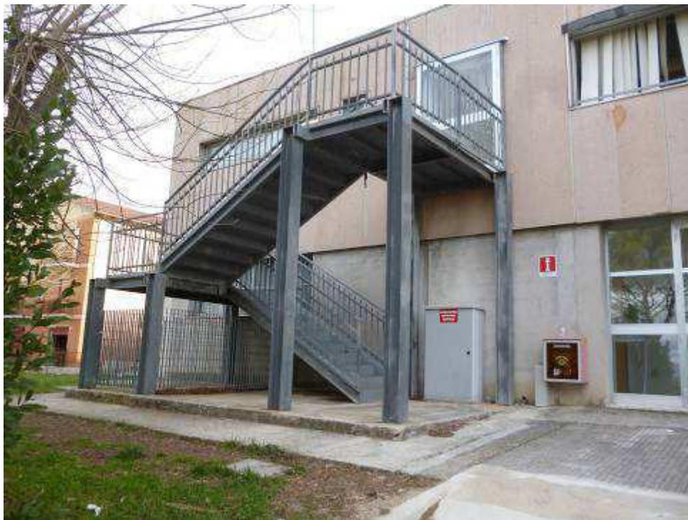
FIG.5: Vista blocco scala uscita di sicurezza
