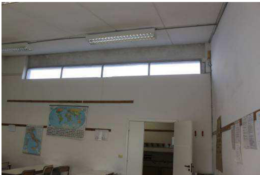
FIG.12: Vista finestre alte interne
