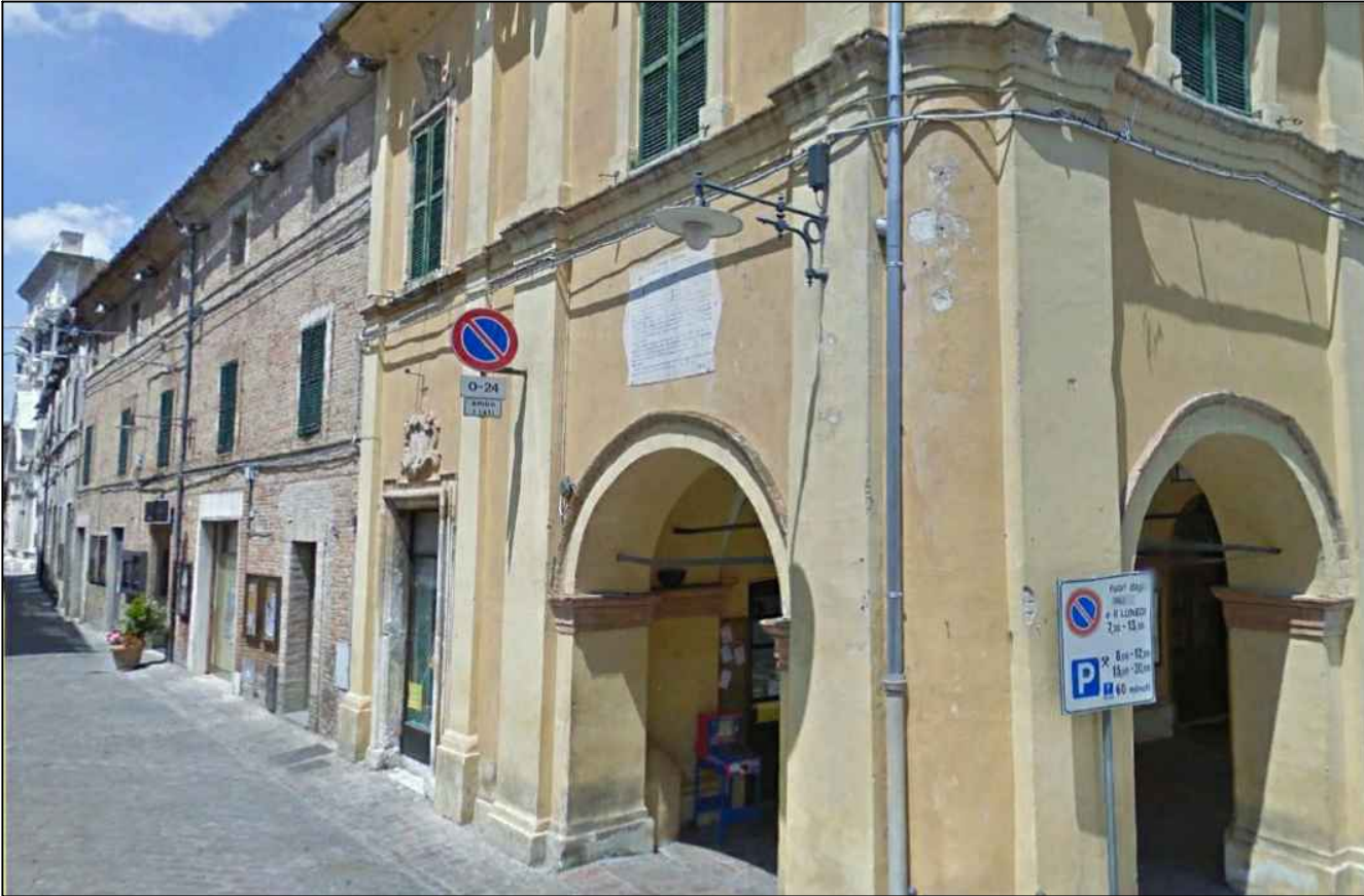
CONSOLIDAMENTO LOCALI A SERVIZIO DEL TEATRO IN VIA ROMA n.29
