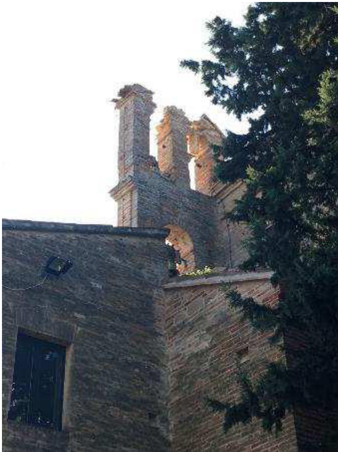
Foto prima dello smontaggio della vela campanaria
