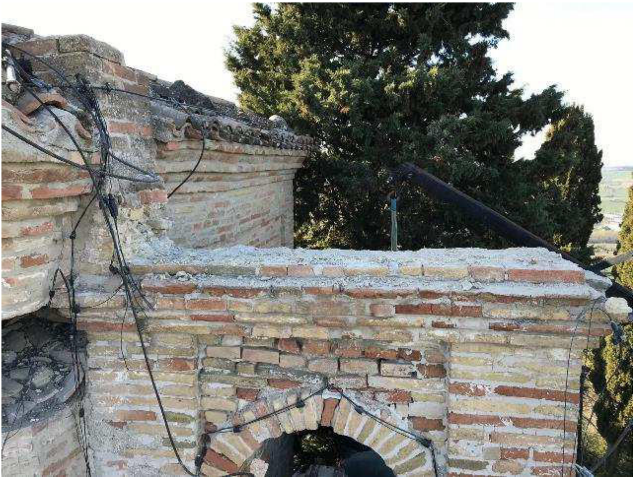
Foto dopo lo smontaggio della vela campanaria
