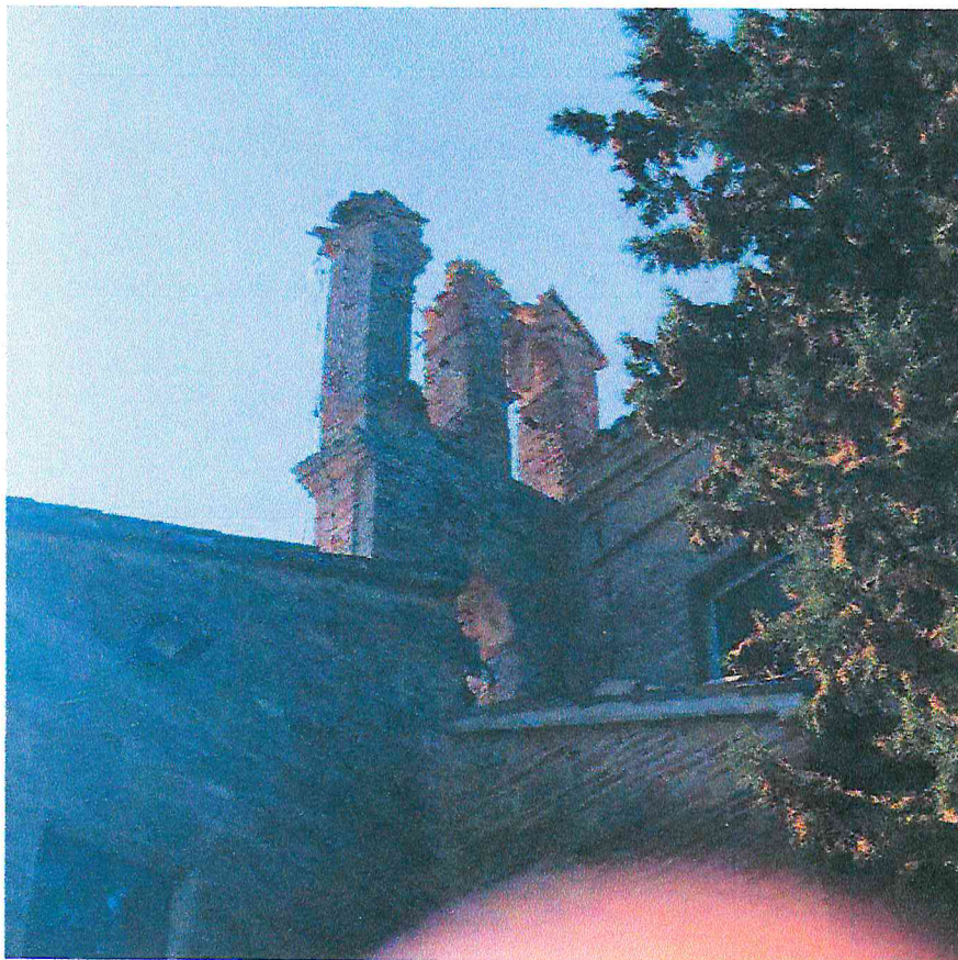
Foto n. 1 – Messa sicurezza vele
