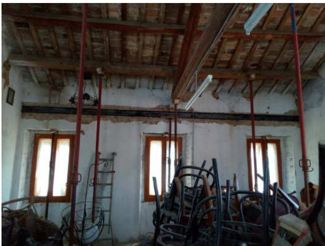
UPN interna in aderenza al muro interno
