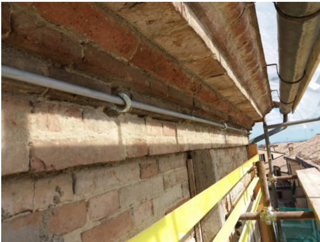
Barra esterna in aderenza al muro esterno
