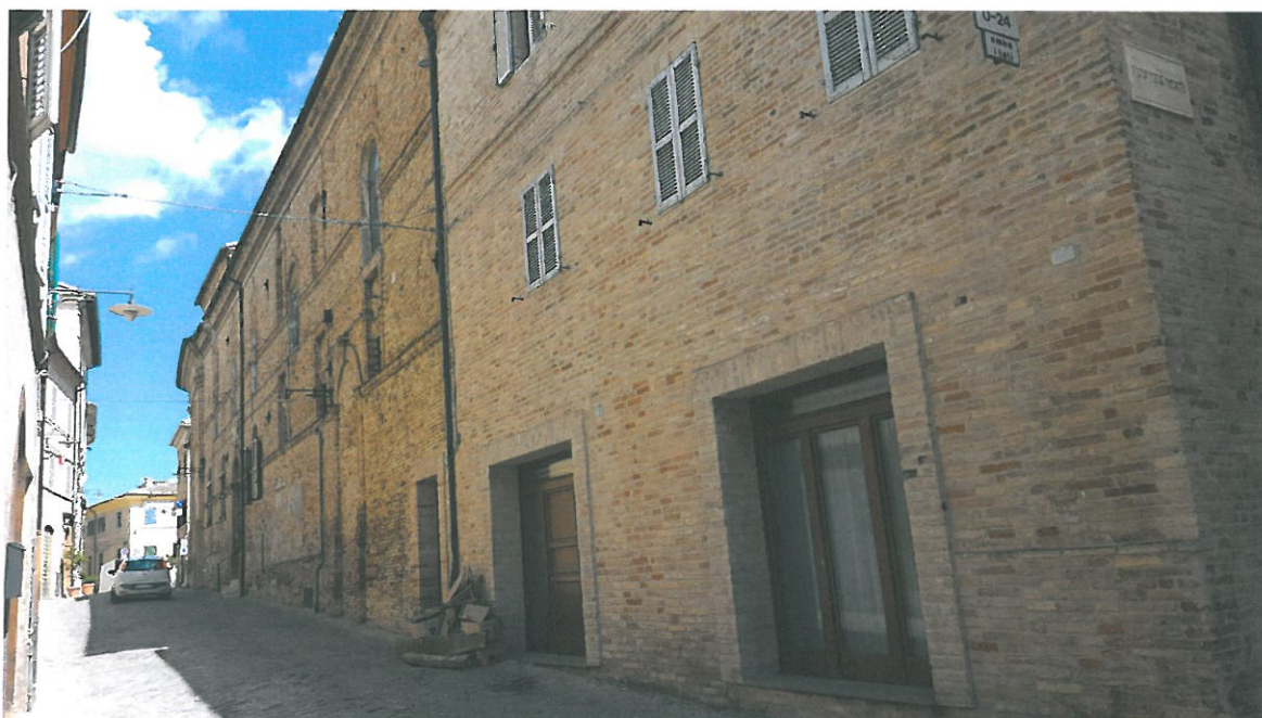
Figura 1. Prospetto su Via Roma
