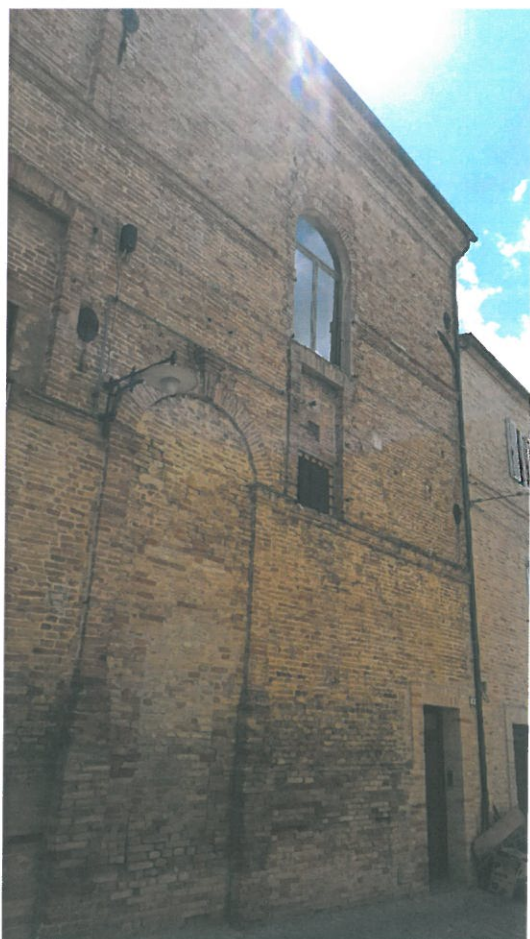
Figura 2. Prospetto su Via Roma
