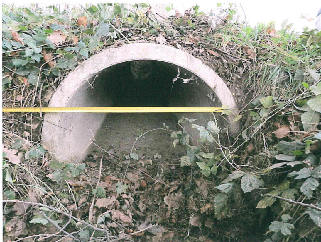
FOTO 4 - tubazione a valle del fosso
